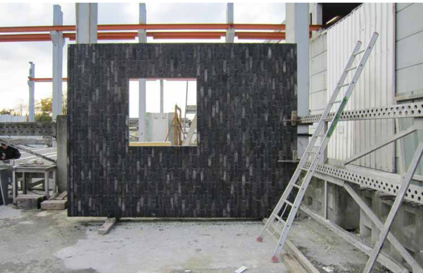
mock-up d'un panneau de façade avec alignement des plaquettes de briques autour de la baie de fenêtre
