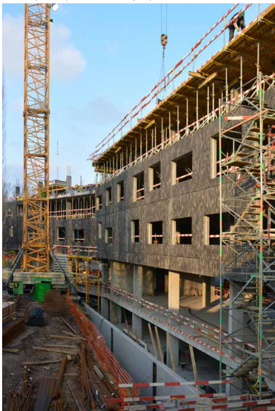
construction phasée du squelette en béton et montage des panneaux de façade
