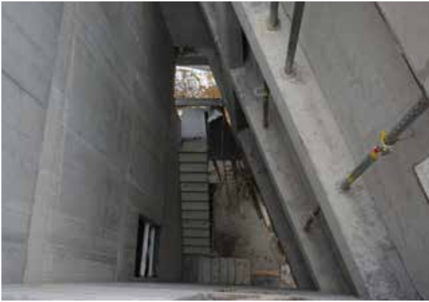
cage d'escaliers, côté est : gros œuvre avec volées d'escalier préfabriquées
