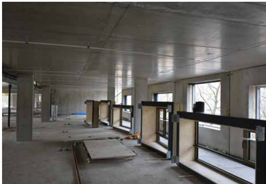
encadrements de fenêtre préfabriqués avant leur montage dans les panneaux de façade
