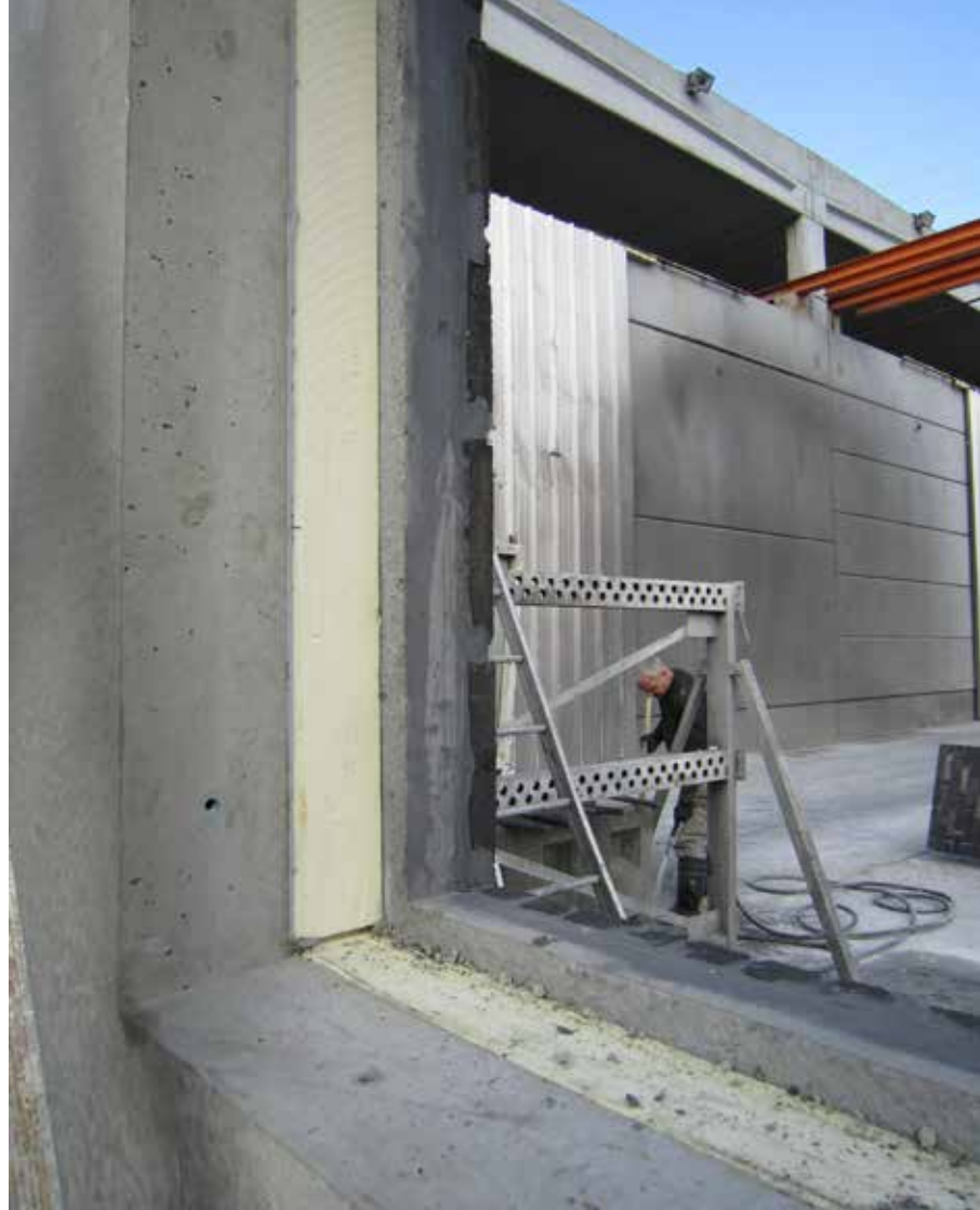
panneau de façade constitué d'un voile intérieur avec surface lissée, d'un isolant et d'un voile extérieur avec plaquettes de brique encastrées
