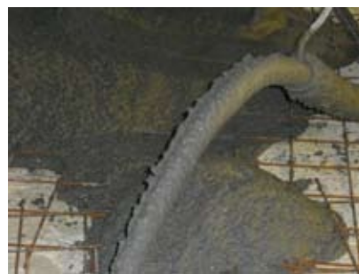
Pompage du béton
