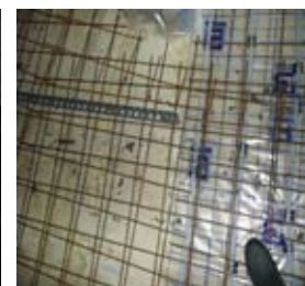
Maintien des armatures par des dispositifs adéquats, avec ou sans chauffage au sol
