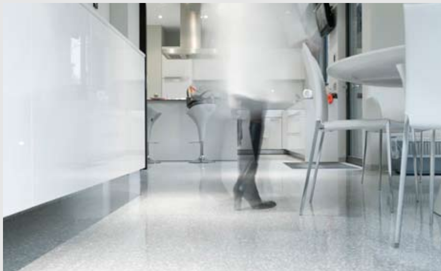
Sol en granito (terrazzo) : couche de finition de 10 à 15 mm contenant un concassé de marbre arch. S. Roose © A. Nullens
