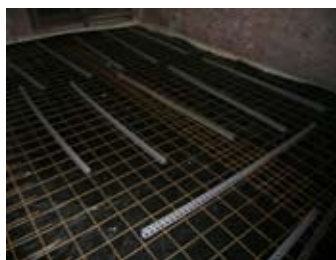
Maintien des armatures par des dispositifs adéquats, avec ou sans chauffage au sol
