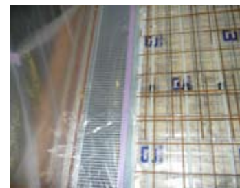
Joint de désolidarisation et protection contre les éclaboussures
