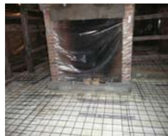
Joint de désolidarisation et protection contre les éclaboussures
