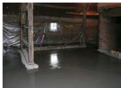
Mise à niveau du béton et vérification au moyen d'un appareil optique au laser
