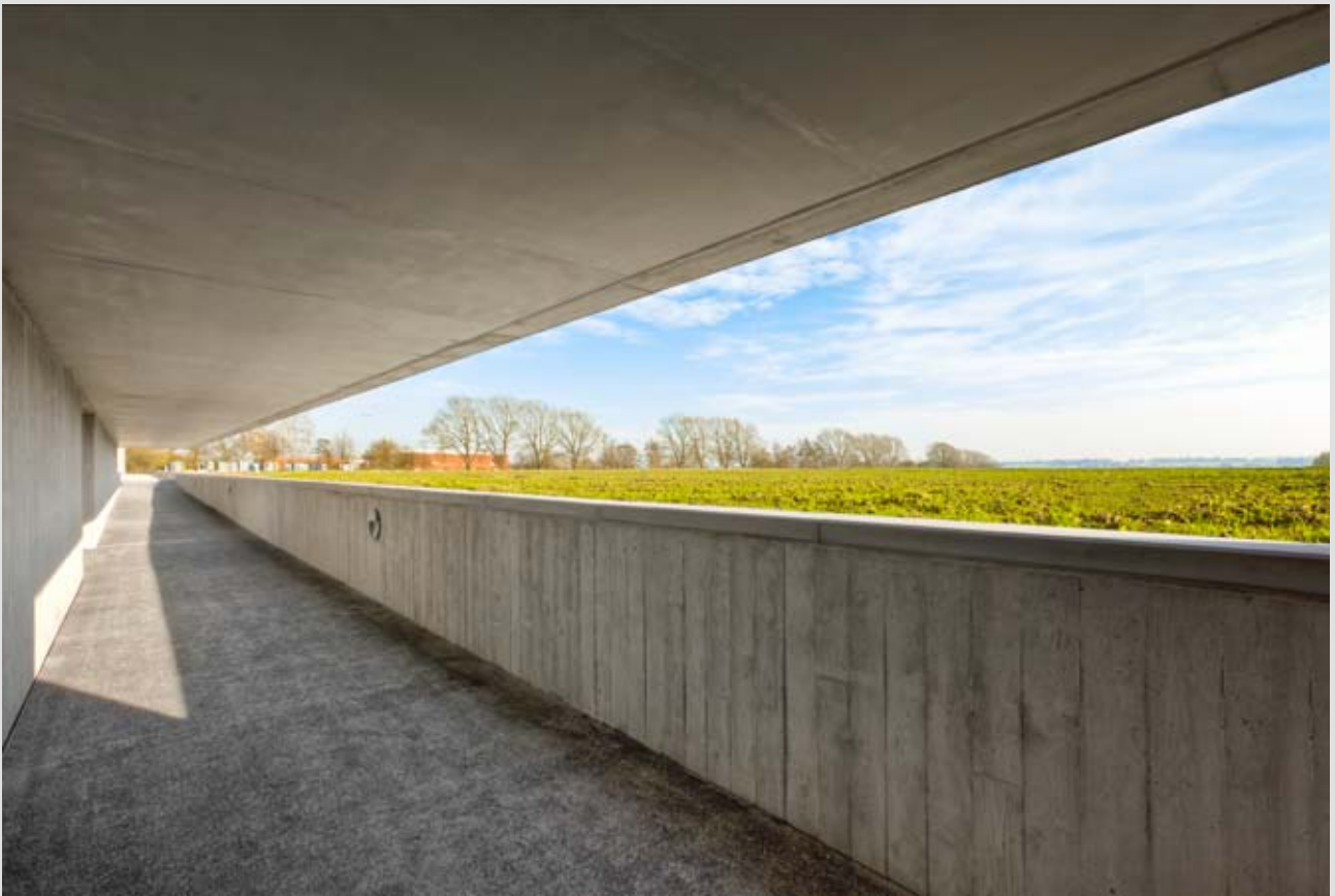
Men verlaat het crematorium via de achterkant van het gebouw, weg van de straat, gericht naar het landschap. Het betreft een zachte overgang naar de buitenwereld en – symbolisch – naar het leven. De architecten hebben gespeeld met diverse betontexturen voor meer reliëf in de volumetrie.
