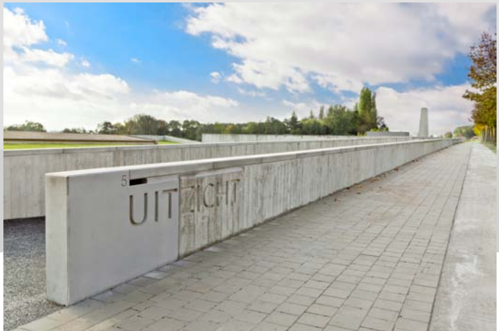
Enkele elementen in zeer glad prefab beton contrasteren met het textuurbeton. Ze beklemtonen het geheel van het gebouw en doen de specifieke plaatsen zoals de ingang beter uitkomen.
