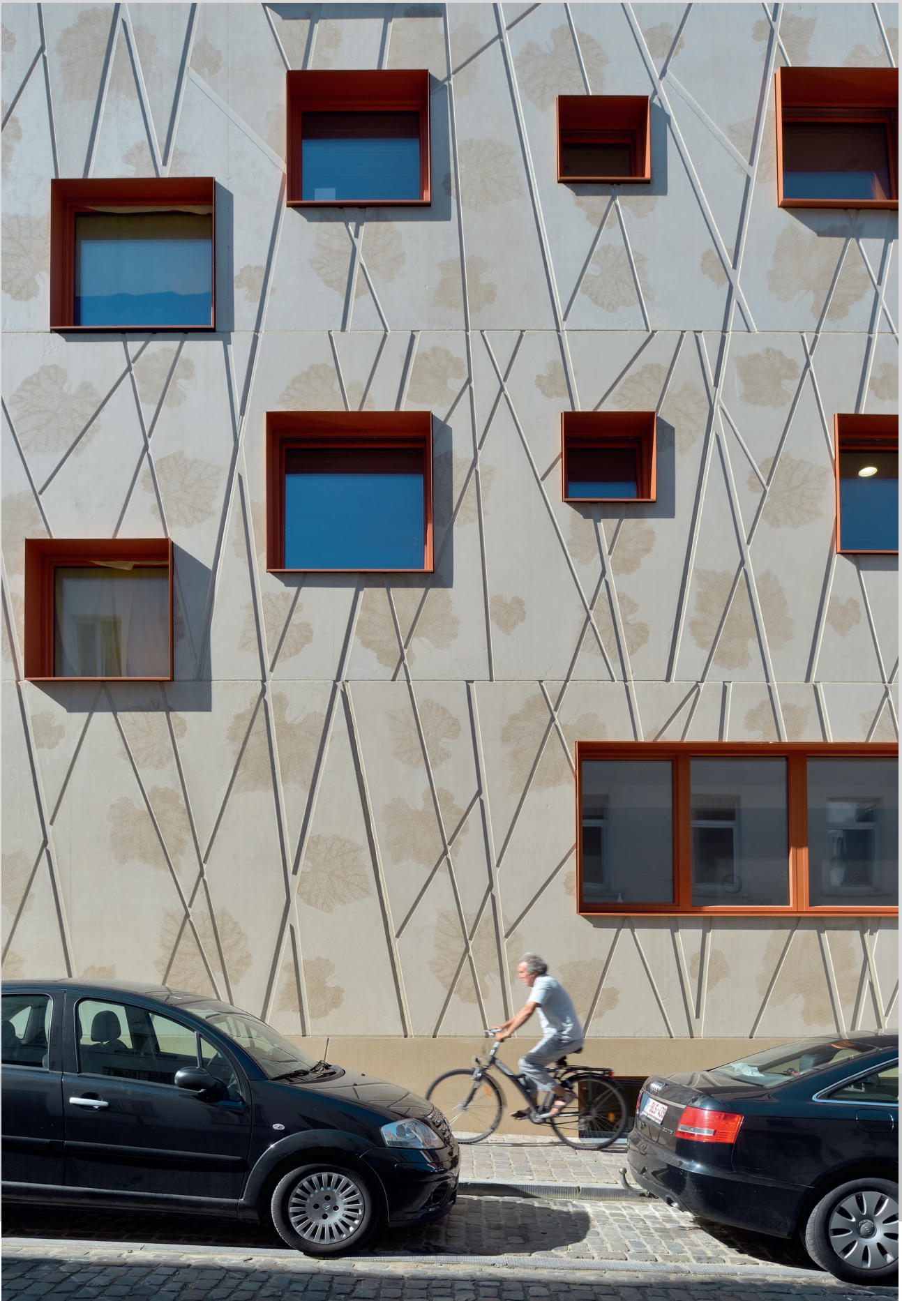
De gevels zijn gerealiseerd in geprefabriceerde panelen in architectonisch beton. Ze zijn gekleurd in de massa en ze tonen een 'print' van plantaardige motieven. Het vakwerkpatroon van de beglaasde zuidgevel komt er eveneens in terug, in de vorm van holle voegen.
