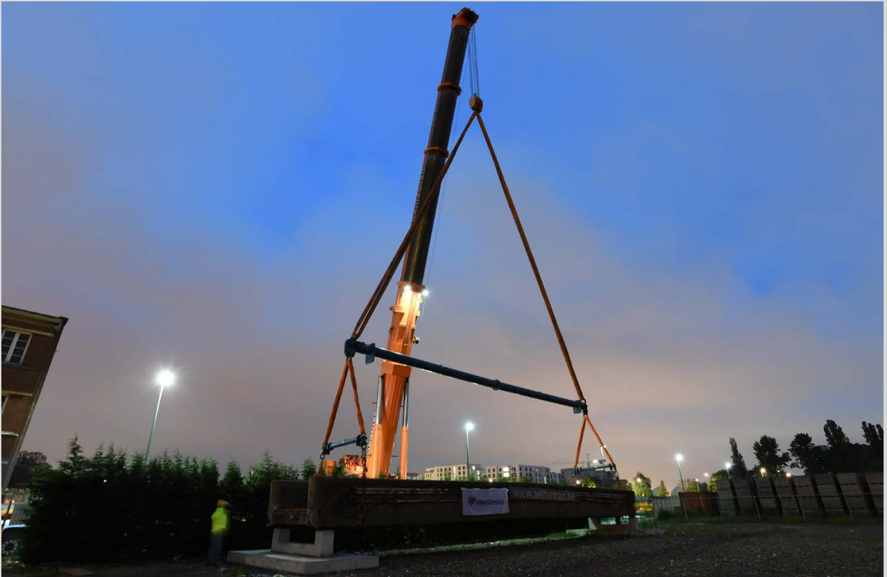
Plaatsing van de voetgangersbrug op het testterrein.
