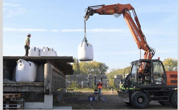
Belasten van de voetgangersbrug met zakken grind van ongeveer 1,5 ton.
