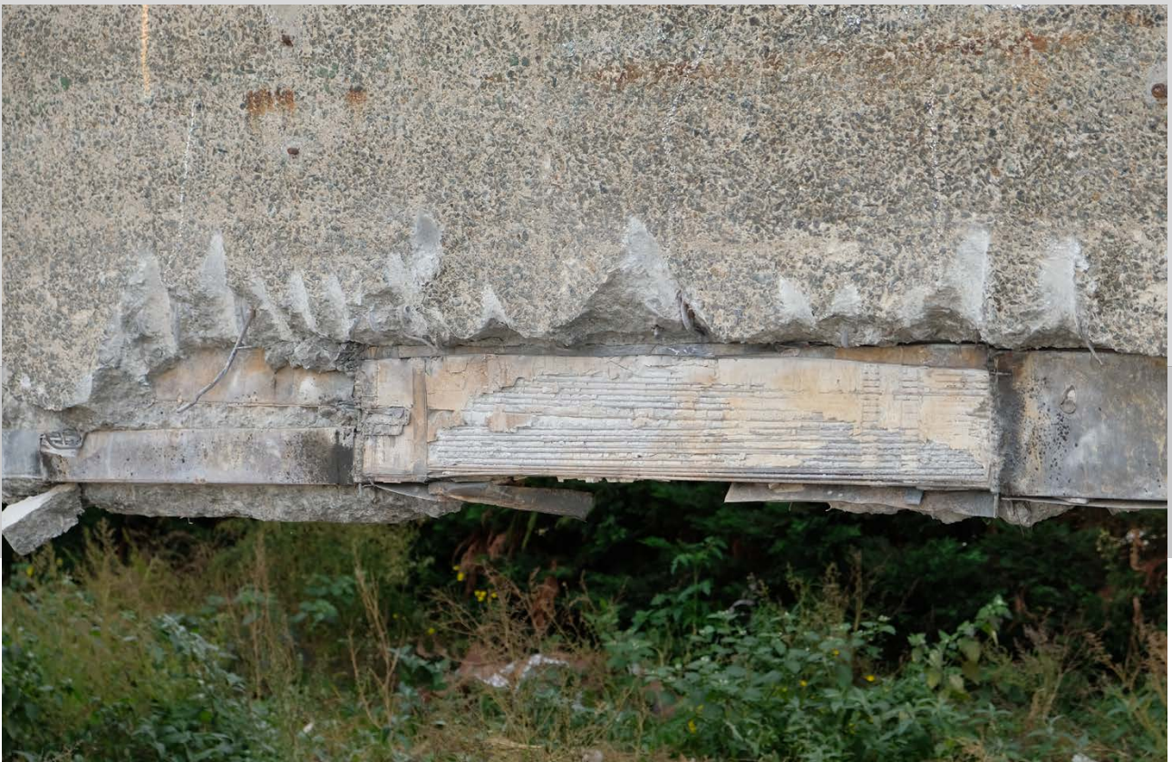
Voorspankabels in het centrale deel van een van de liggers na verwijdering van de metalen beschermkoker. Cementmortel beschermt de staalkabels.
