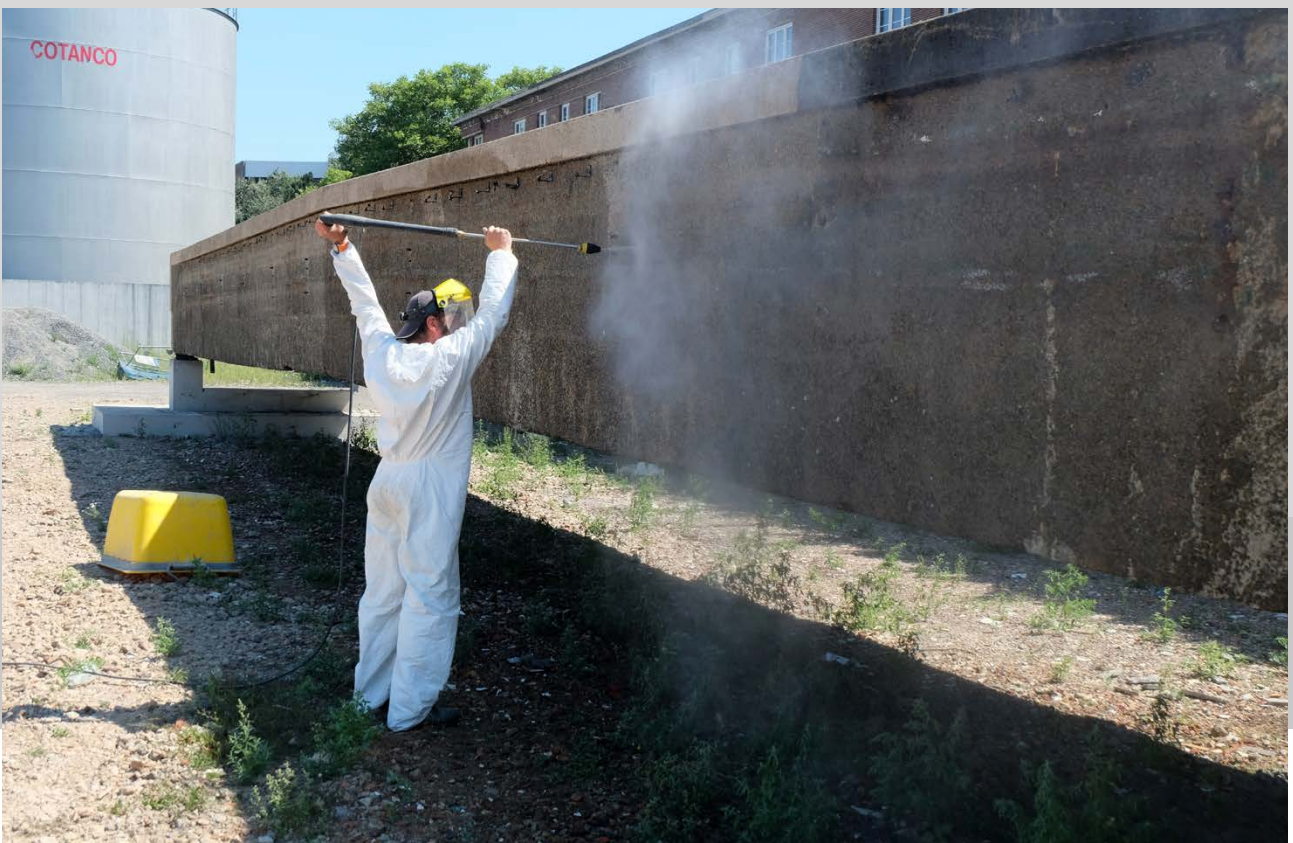
Schoonmaken van de brug met hogedrukreiniger.
