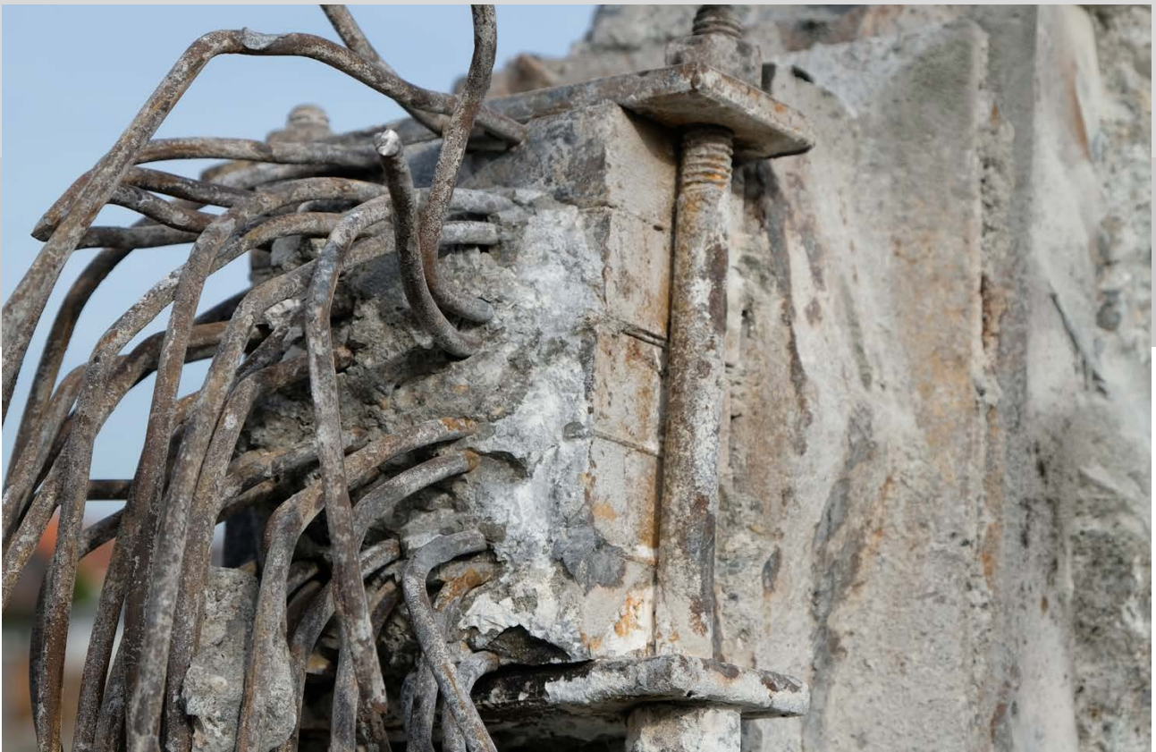
Vrijgemaakt eindanker van een kabel tijdens de afbraak.
