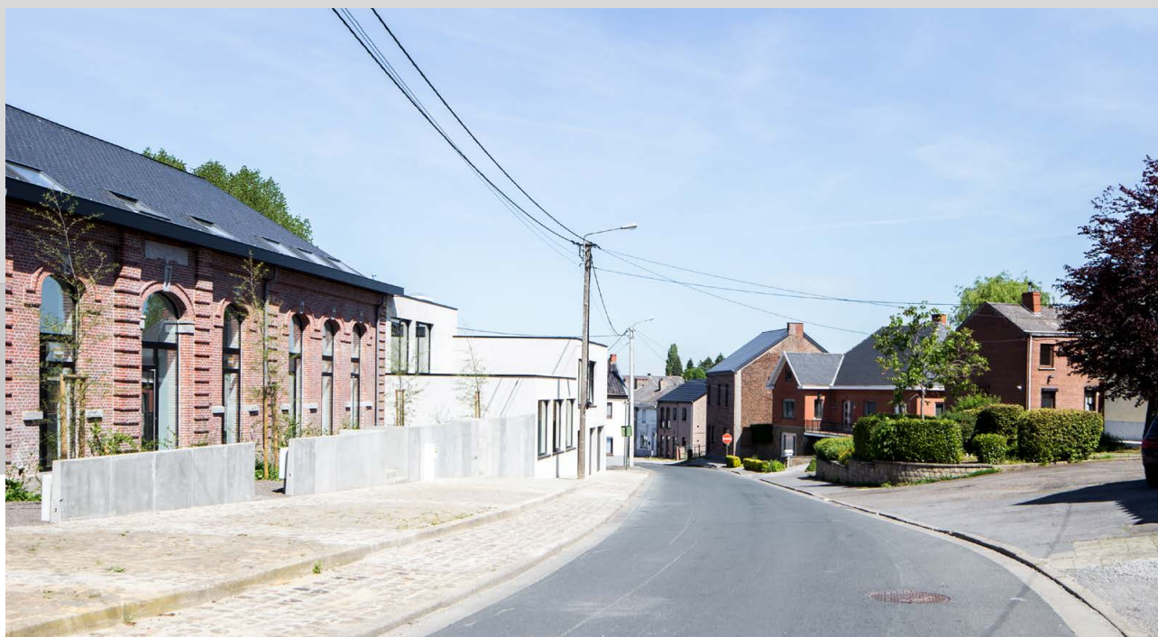
Het project is mooi geïntegreerd in de gebouwde context: strakke volumes respecteren zowel de bouwprofielen van de aanpalende constructies als de noden van het architectenbureau op het vlak van ruimte en functionele organisatie. De eenvoudige behandeling van de gevel zorgt voor de nodige rust in een heterogene bebouwde omgeving.
