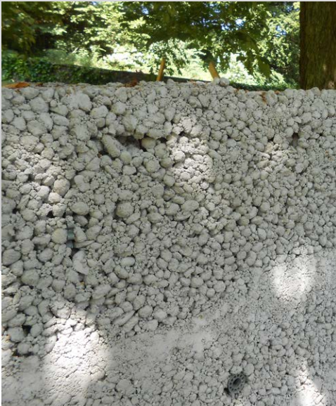
Borstwering in stampbeton. De uitvoering van een werk in stampbeton verloopt vrij complex: er wordt een roestvrije wapening gebruikt en de bekisting wordt snel verwijderd. De lagenaardvochtig beton moeten voldoende dik zijn.
