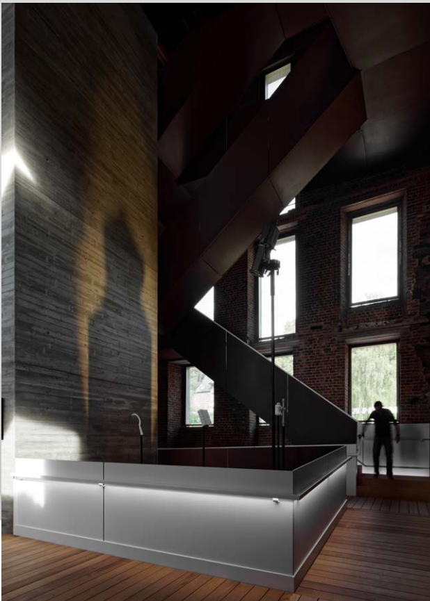
De verbluffende liftkoker in plankjesbeton past in chromatische harmonie bij de baksteen, het hout en het cortenstaal.
