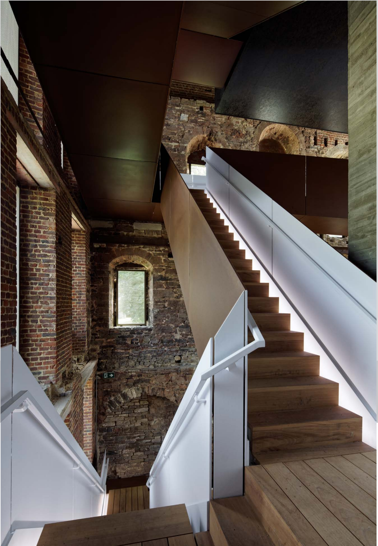
De grote trap combineert cortenstaal, hout en multiplex
