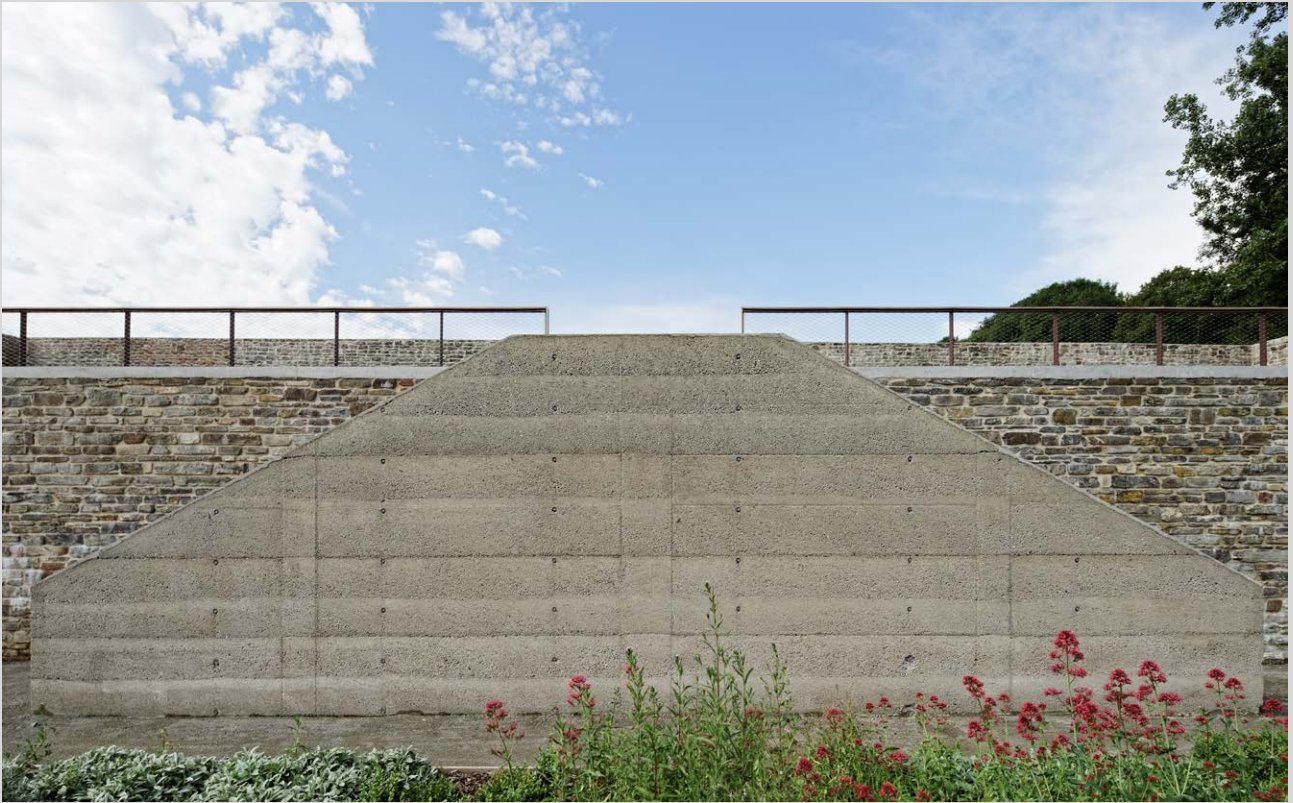
De borstwering in stampbeton is niet alleen functioneel maar heeft ook de allure van een monumentale sculptuur.
