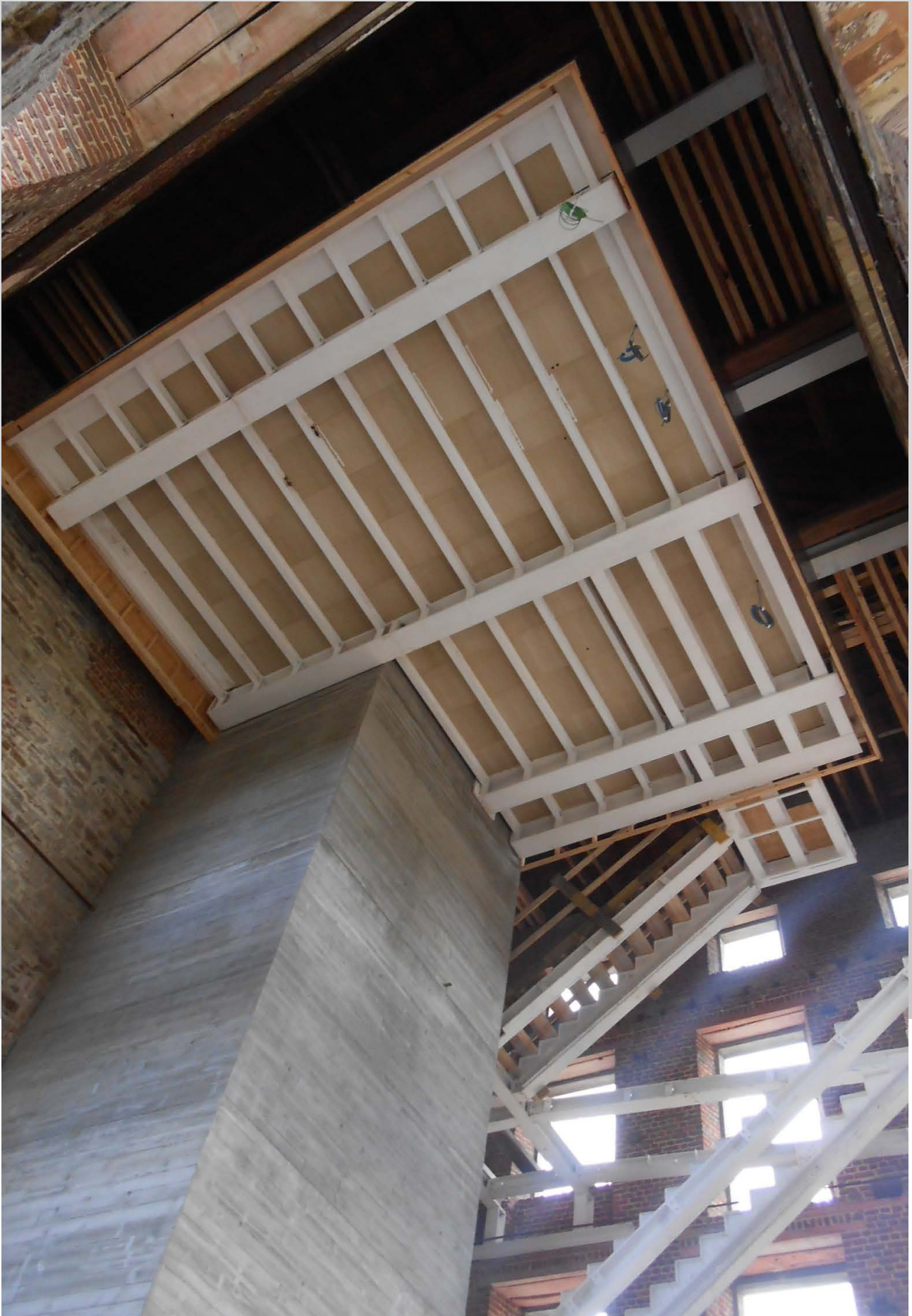
De uitvoering van de liftkoker in plankjesbeton verliep niet van een leien dakje: de aannemer heeft heel wat proeven moeten doen voor hij de juiste formule gevonden had.
