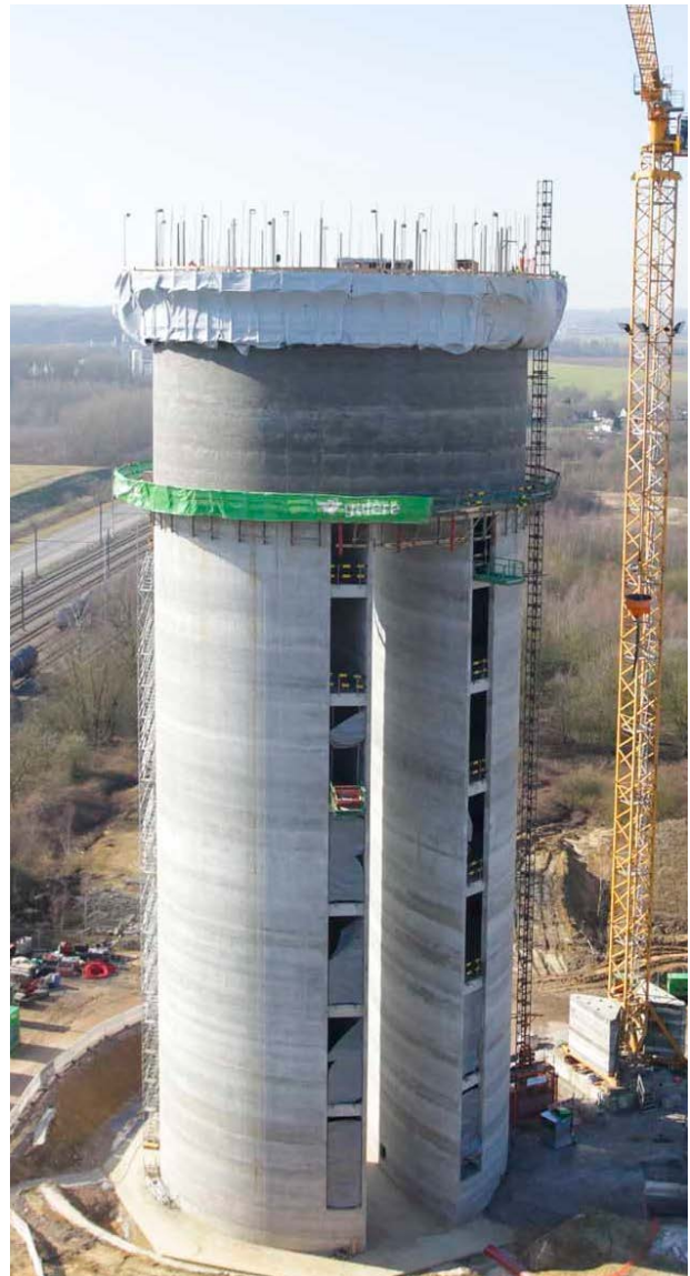
De tweede fase, met de buitenschil en de 12,80 meter hoge wanden van het reservoir, nam 5 dagen in beslag. Daarna moet alleen nog de betonnen dakkoepel geplaatst worden.
