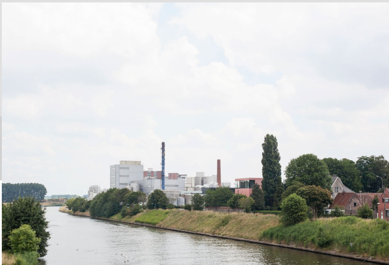
De gevels van het project zijn uitgevoerd in prefab betonpanelen. Het gebouw ligt op de rand van een industriezone, vlak bij woningen in rode baksteen. De bewust gekozen lichtroze tint zorgt voor een zachte overgang in dit contrastrijke landschap.
