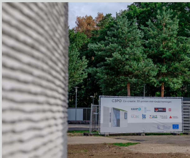
Kamp C en C3PO konden voor de constructie van deze eerste 3D-geprinte woning rekenen op zeven andere partners: bouwbedrijf Beneens, ETIB/Concrete House, Groep Van Roey, ViCre, Thomas More, architectenbureau Trias architecten en Universiteit Gent. Ook Saint-Gobain Weber werkte mee aan het avontuur.
