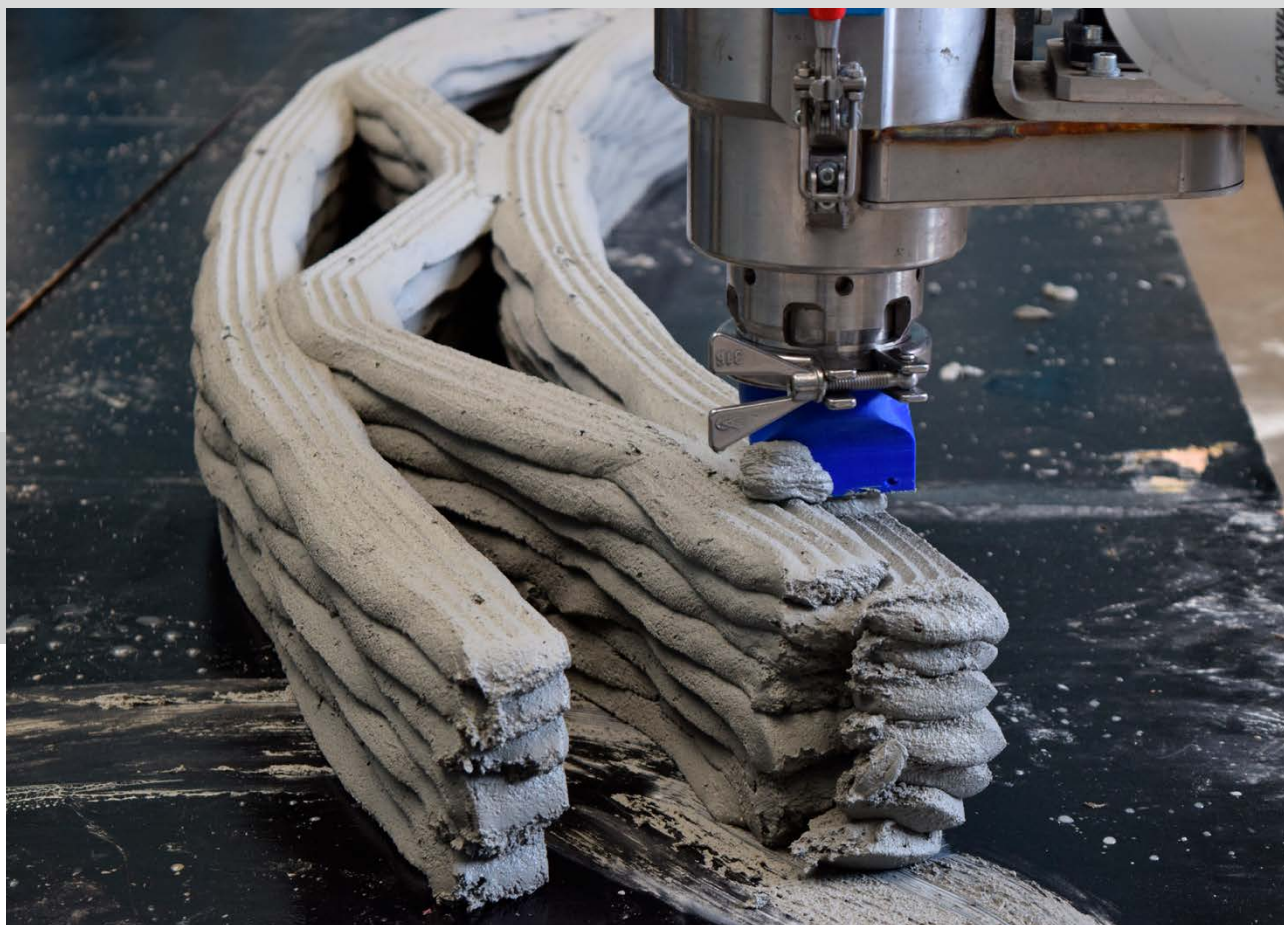
De printer bouwt holle dragende muren waarvan de draagkracht gelijk is aan die van een structurele muur in traditioneel betonmetselwerk. Dit 'traliwerkpatroon' wordt mogelijk gemaakt door de vrijheid van creatie en realisatie van 3D-printing.
