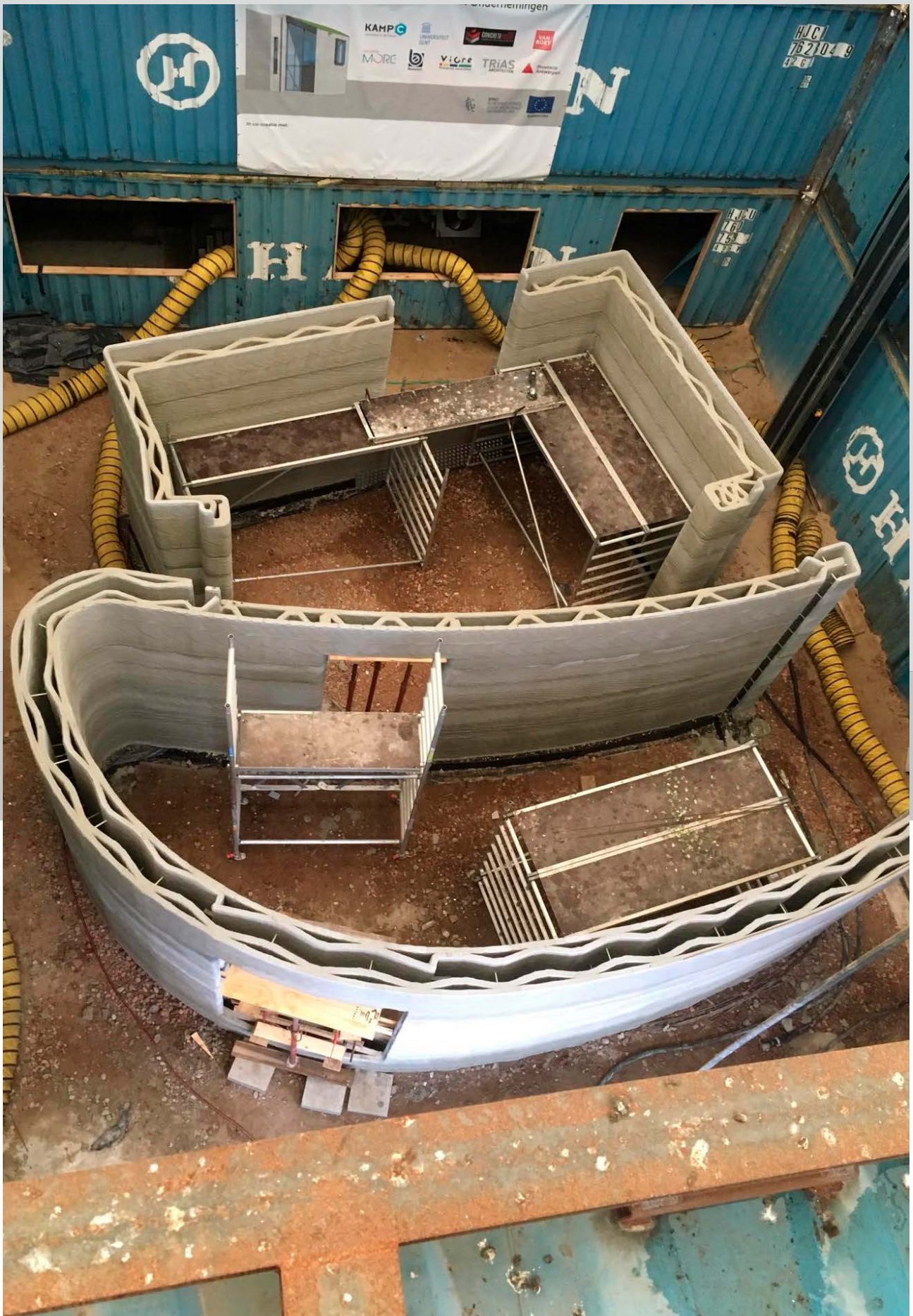
Met deze realisatie in Kamp C werd de 3D-printtechniek in beton uitgeprobeerd. Afmetingen, vormen, muurdiktes, integratie van speciale technieken: het project werd ontworpen om het procedé te testen en te verbeteren.
