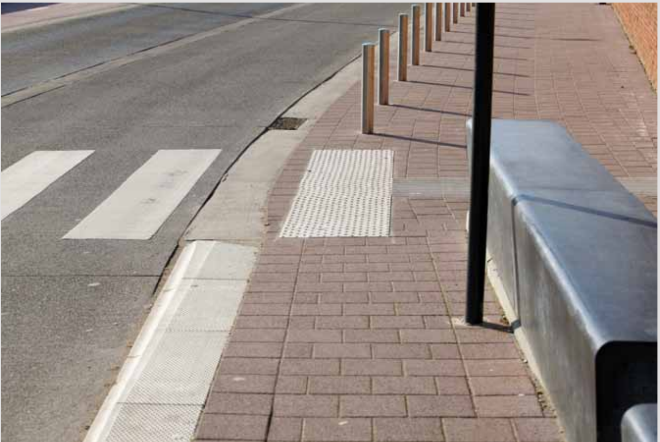
Ook de bushalte in de Pastoor Dergentlaan werd volledig met prefab betonnen materialen aangelegd.
