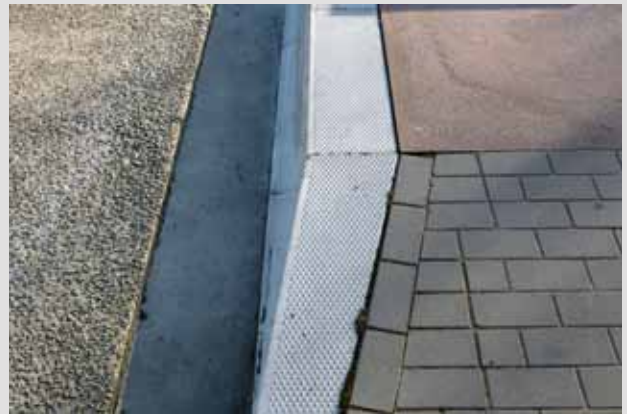
Op de parking Demervallei werd een bushalteplaats ingericht met geprefabriceerde betonnen perronplaten en met aangepaste witte busboordstenen. Het geheel werd verfraaid met modern betonnen straatmeubilair.
