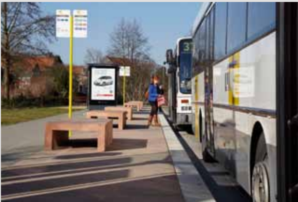
Op de parking Demervallei werd een bushalteplaats ingericht met geprefabriceerde betonnen perronplaten en met aangepaste witte busboordstenen. Het geheel werd verfraaid met modern betonnen straatmeubilair.
