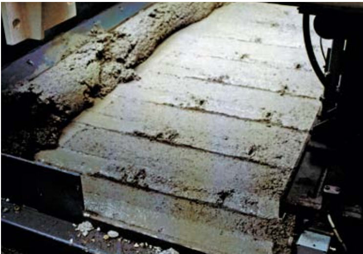
Les goujons sont introduits dans le béton frais par vibration lors du passage de la machine à coffrage glissant.
