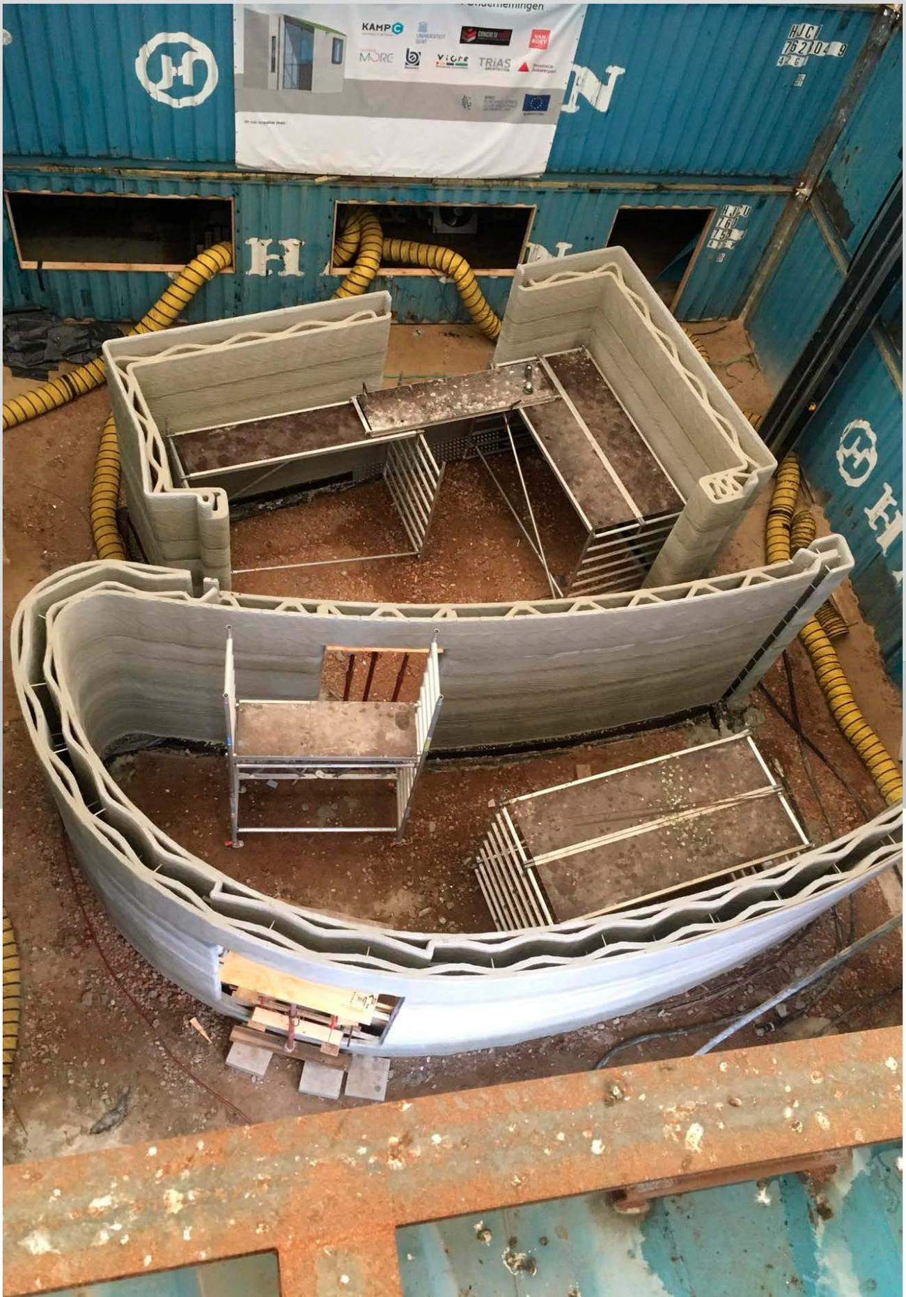
Le projet porté par Kamp C a éprouvé la technique d'impression 3D en béton. Dimensions, formes, épaisseurs de mur, intégration des techniques spéciales : le projet a été conçu pour tester et améliorer le procédé.
