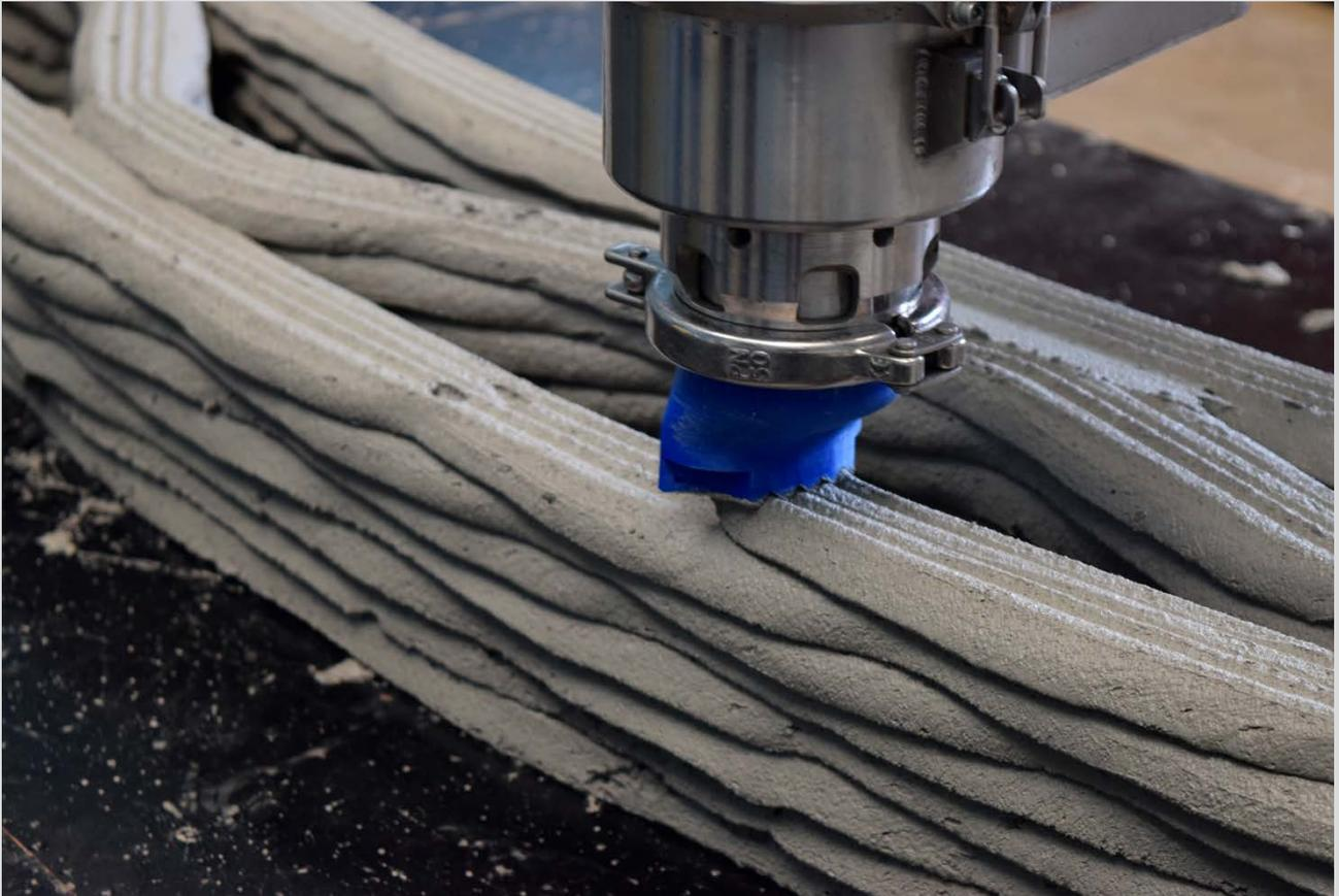
Par passes successives, l'imprimante superpose des couches de mortier de quinze millimètres. La vitesse d'impression est de 250 millimètres par seconde. Dans le cadre de ce projet, l'impression de chaque couche a duré huit minutes et il a fallu quinze jours pour achever la phase « gros-œuvre » du chantier.
