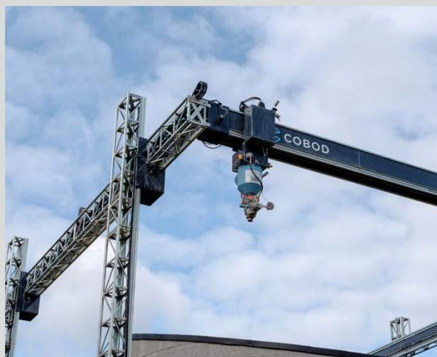
La maison a été modélisée en 3 dimensions via un logiciel informatique approprié. Le modèle est ensuite transmis à l'imprimante 3D qui l'exécute in situ. L'imprimante utilisée est un modèle fixe, qui est le plus grand existant en Europe. Sa taille permet d'imprimer en un seul tenant des projets de dimension relativement importante.
