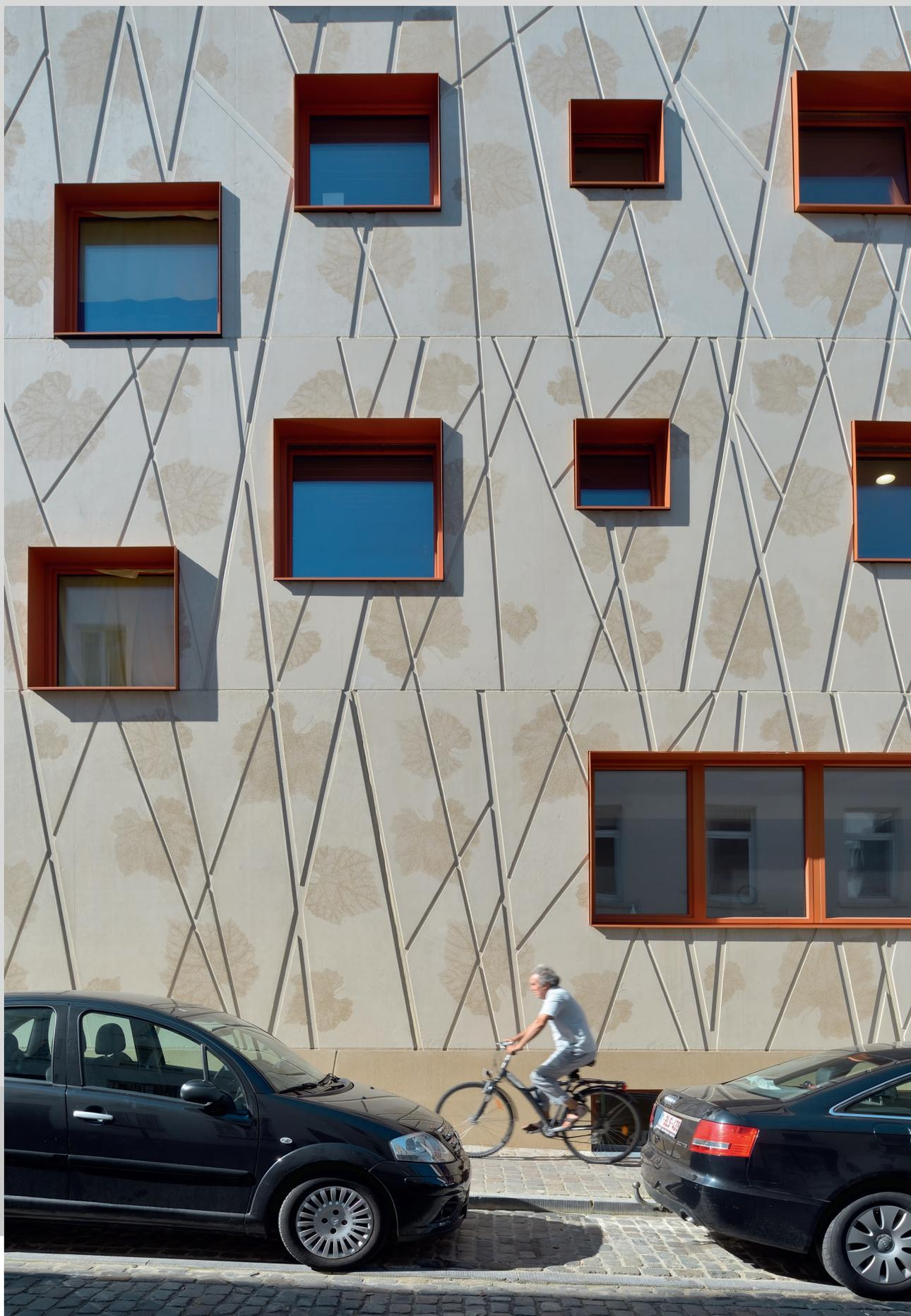
Le parement des façades de la crèche sont réalisés en panneaux de béton architectonique préfabriqués. Ils sont colorés dans la masse et donnent à voir une « impression » de motifs végétaux. Le dessin des poutres-treillis de la façade sud vitrée s'y retrouvent également, sous forme de joints creux.
