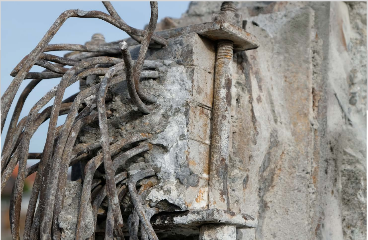
Ancrage d'extrémité d'un câble dégagé lors de la démolition de la passerelle.
