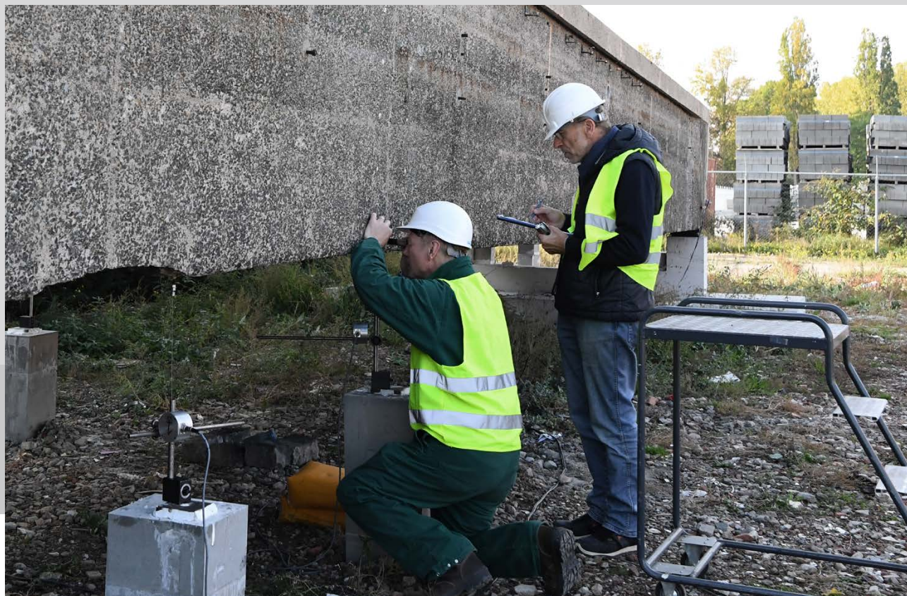
Mesure de l'ouverture des fissures sur la face latérale d'une des poutres.
