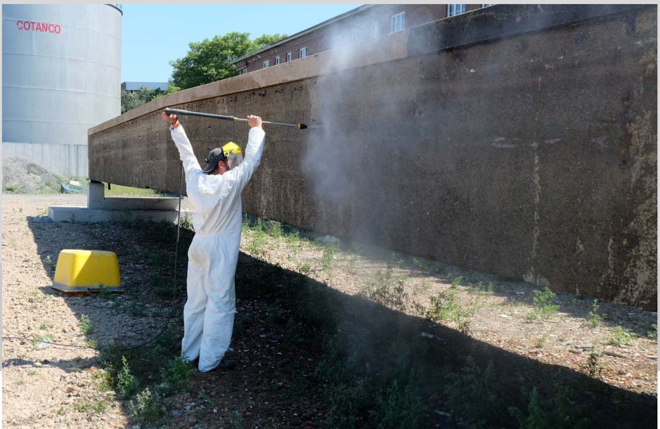
Nettoyage de la passerelle par eau à haute pression.
