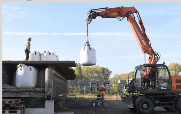
Mise en charge de la passerelle par des sacs d'environ 1,5 tonnes de gravier.
