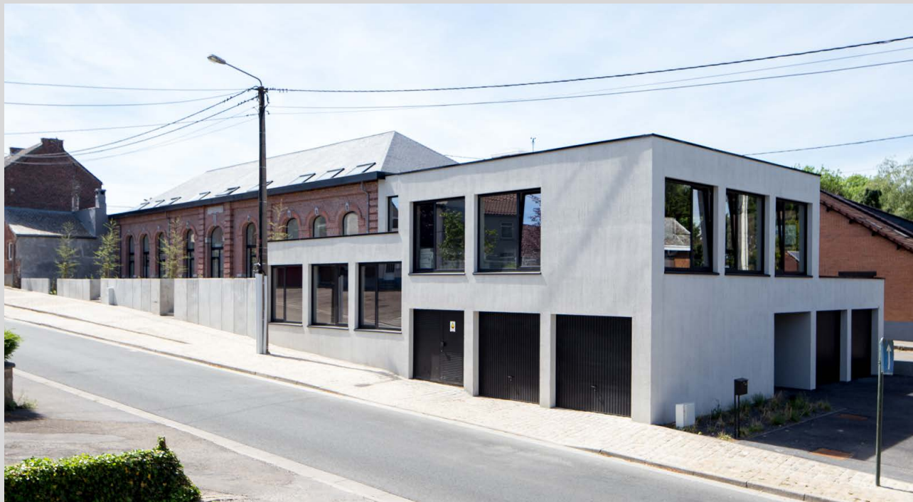
La nouvelle construction accueille les bureaux de l'équipe d'architectes, auteurs de projet. Elle s'implante à la place d'anciennes annexes datant des années 60 et ne présentant aucun intérêt particulier. Le dialogue avec l'ancienne école joue sur le contraste de vocabulaire architectural.
