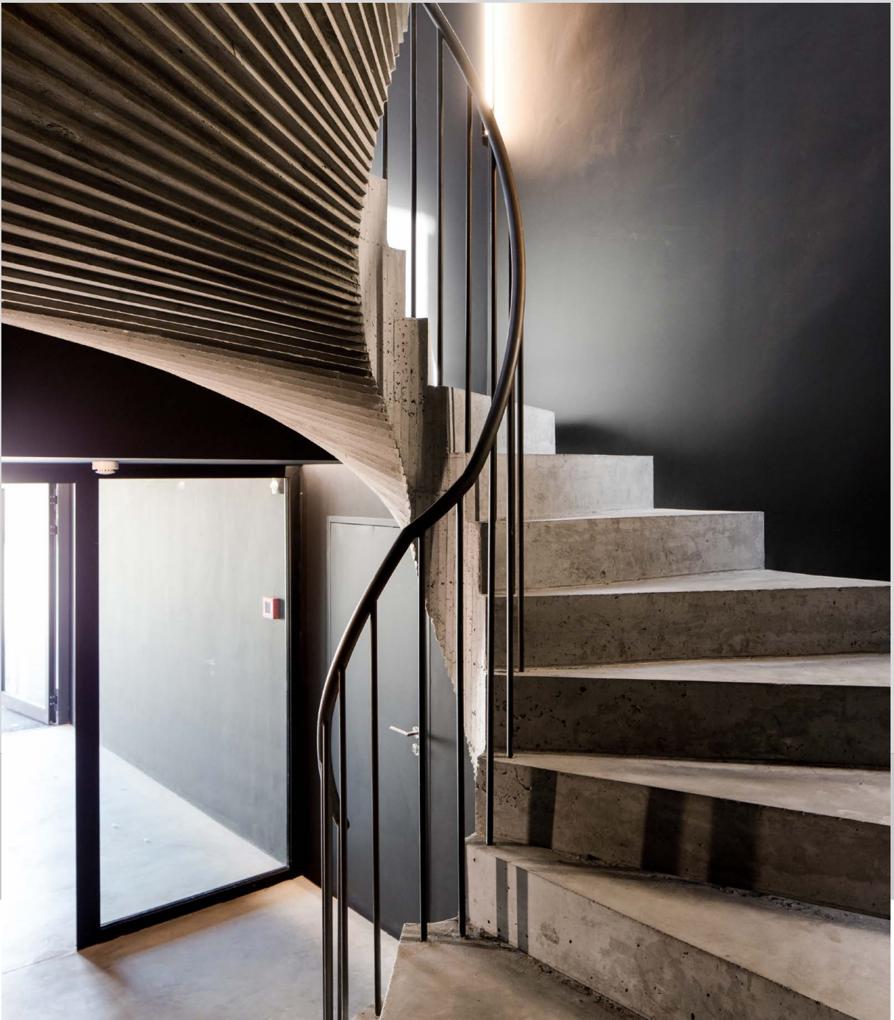
Un escalier sculptural se trouve au centre du projet. Réalisé en béton coulé en place, il est un véritable trait d'union entre tous les espaces de travail. Son aspect visuel montre la possibilité d'employer le béton de manière noble et esthétique.
