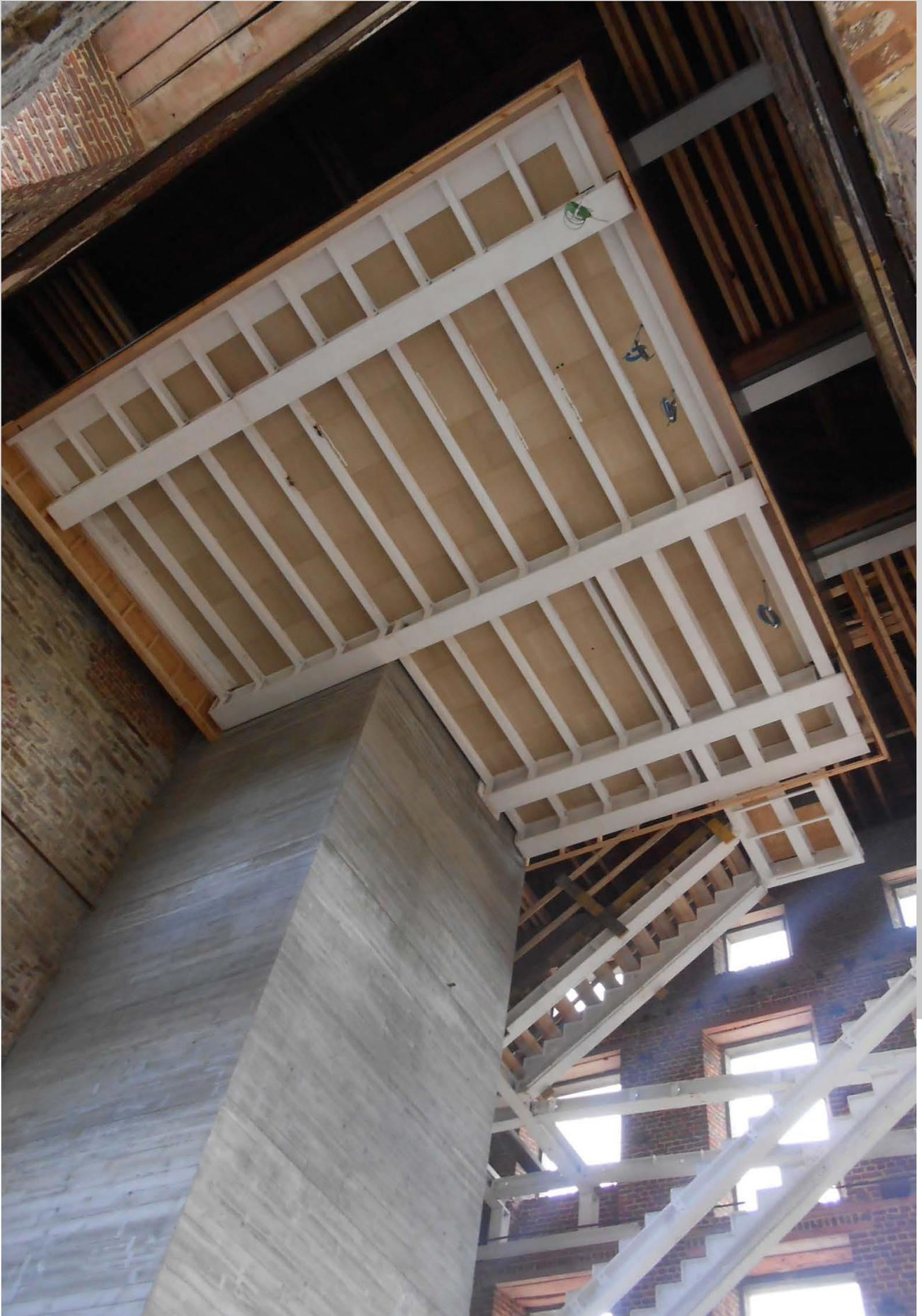
La réalisation de la cage d'ascenseur en béton voliges n'a pas été sans mal. Il a fallu procéder à de nombreux essais avec l'entreprise avant de trouver la formule qui convenait.
