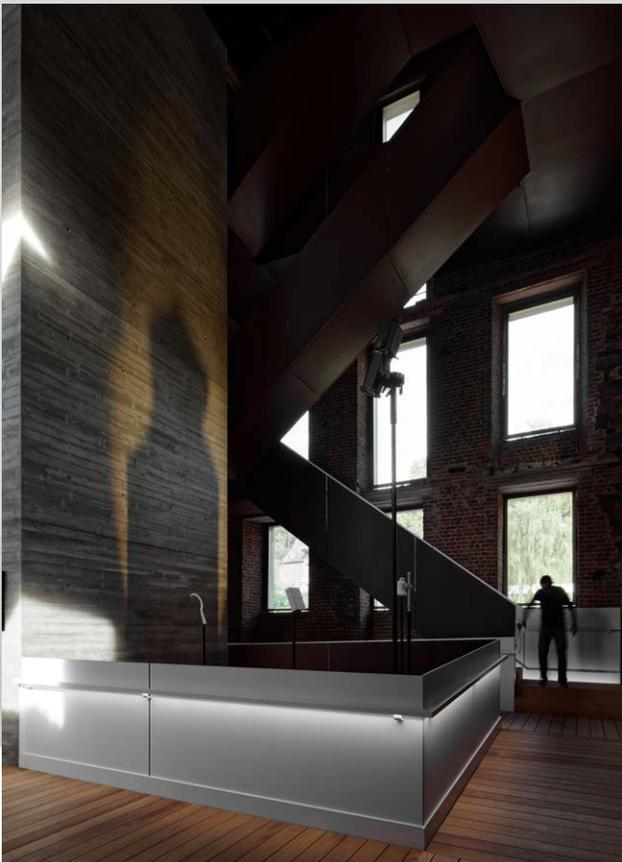
L'étonnante cage d'ascenseur en béton voliges s'harmonise chromatiquement avec la brique, le bois et l'acier Corten.
