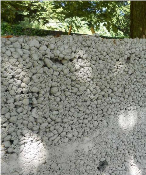
Garde-corps en béton pisé. L'exécution d'un ouvrage en béton pisé est assez complexe : on utilise un ferrillage en inox et on décoffre tout de suite, mais il faut éviter les coulées et faire en sorte que les strates soient suffisamment espacées
