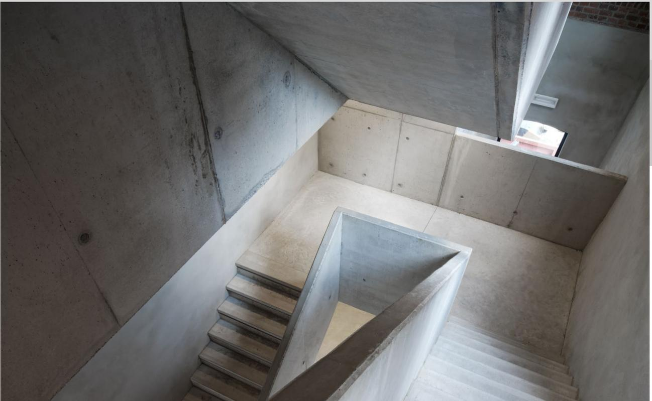
Nécessitant moins d'appui, un escalier en béton permet de créer des porte-à-faux.
