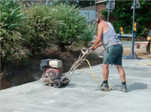
Sciage des joints de retrait transversaux. En raison des températures élevées, cette étape est déjà intervenue environ 6 heures après le bétonnage
