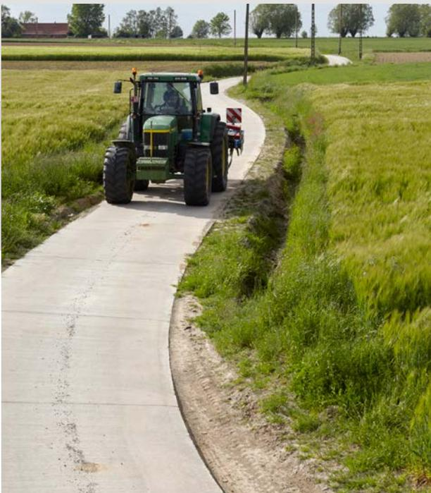
À Herne et à Biévène, un certain nombre de ces routes agricoles se trouvaient dans un piteux état et nécessitaient une réhabilitation complète. Il s'agissait au total d'un tracé linéaire de 6 km, dont 3,5 km ont été reconstruits en béton et 2,5 km en asphalté. Les travaux ont été effectués au cours du deuxième semestre de 2015 et début 2016.
