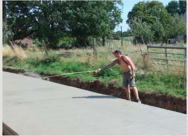
Protection du béton frais contre la dessiccation par la pulvérisation d'un produit de cure (curing compound)
