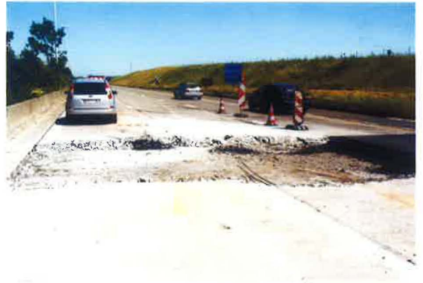
Afb. 31 – Uitbraak ter hoogte van een opstuiking van een weg in doorgaand gewapend beton
