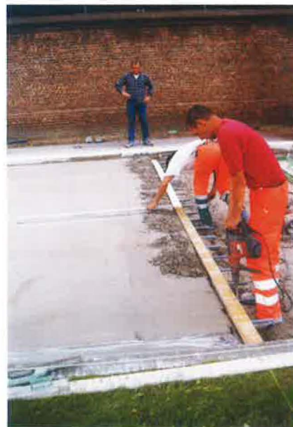
Verzorgde uitvoering van een einddagvoeg in het geval van een verharding in gedevelde betonplaten
