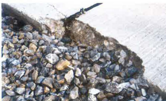
Afb. 12 – Afsplijten van het beton ter hoogte van een uitzetvoeg doordat de voegplaat niet tot de rand van de verharding reikt
