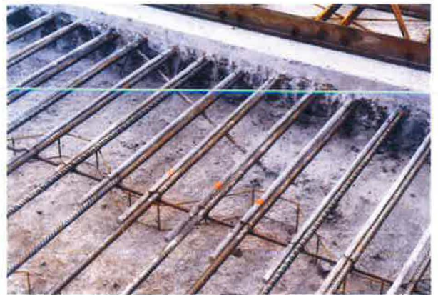
Afb. 32 – Vrijmaken van de langse wapeningsstaven over +/- 1 m aan beide uiteinden van de herstelling. Let op hoe het beton op perfect verticale wijze werd verwijderd onder de gerecupereerde wapening
