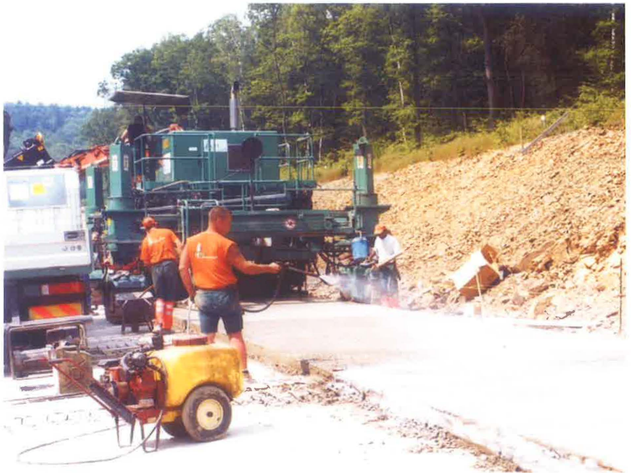
De bescherming tegen uitdroging van het beton onmiddellijk na het storten is een cruciale fase in de aanleg van een wegdek in cementbeton
