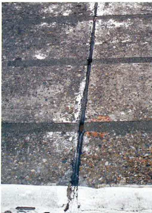
Afb. 26 - Dwarsvoeg waarin de lastoverdracht werd hersteld door inbrenging van deuvels in het verhard beton
