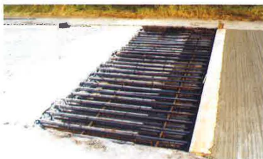
Afb. 35 – Betonning van een langere herstelzone in meerdere fasen door middel van sluitstukken. Deze worden aan beide uiteinden en minstens drie dagen na de centrale zone gebetonneerd
