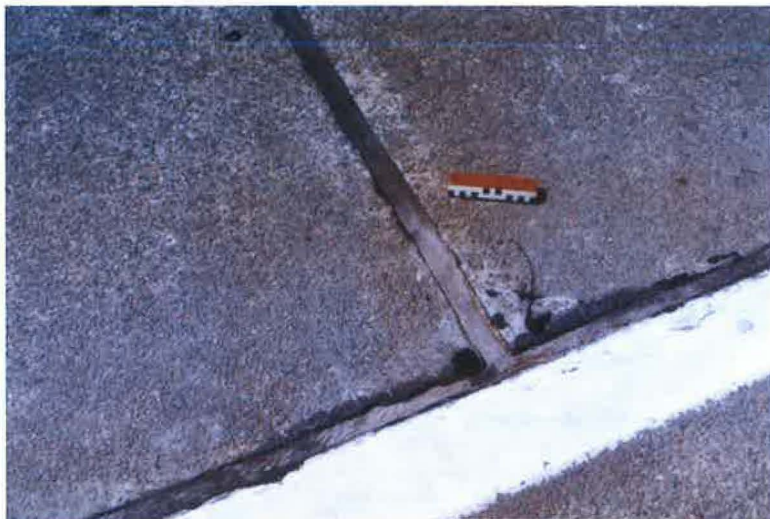
Afb. 20 – Nieuwe voegvulling van een oude betonweg
