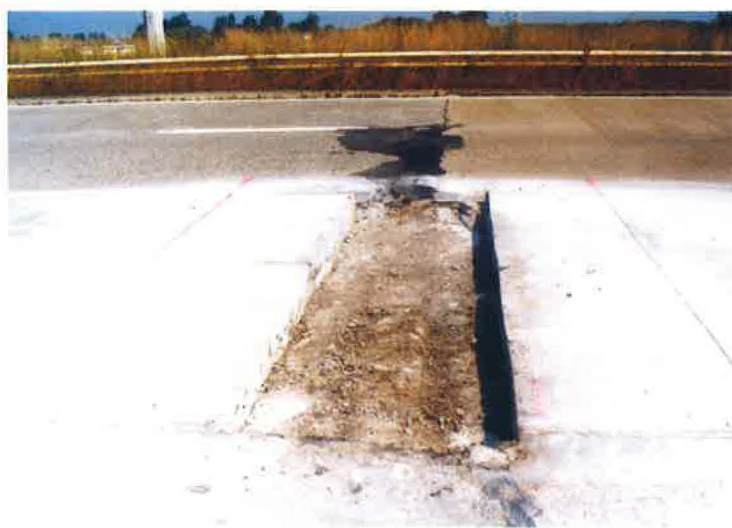
Afb. 29 – Herstelling ter hoogte van een werkvoeg. Let op de zaagsneden over volledige dikte en de twee sneden van beide uiteinden van de herstelling teneinde de langsstaven vrij te maken
