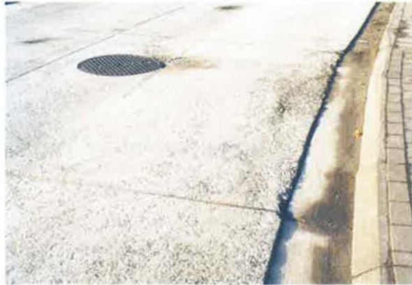
Afb. 9 – Lokale schade van het beton ten gevolge van het handmatig bijwerken ervan. Let ook op het foute voegenpatroon ten opzichte van het vast element
