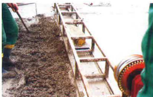
Afb. 36 – Verwerking van het beton met de trilbalk. Langsbeen de zijranden wordt het beton bijkomend verdicht met de trilnaald
