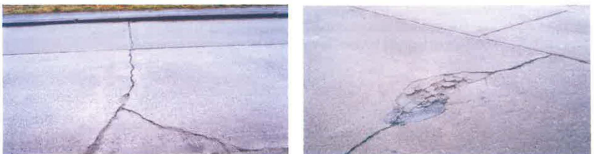
Afb. 18 – Voorbeeld van een scheur in een oude betonverharding (verspringende voeg-sympathiescheur) en voorbeeld van de schade-evolutie van een scheur (afschilferen en afbrokkelen van de scheurranden)
