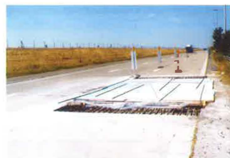
Afb. 35 – Betonning van een langere herstelzone in meerdere fasen door middel van sluitstukken. Deze worden aan beide uiteinden en minstens drie dagen na de centrale zone gebetonneerd
