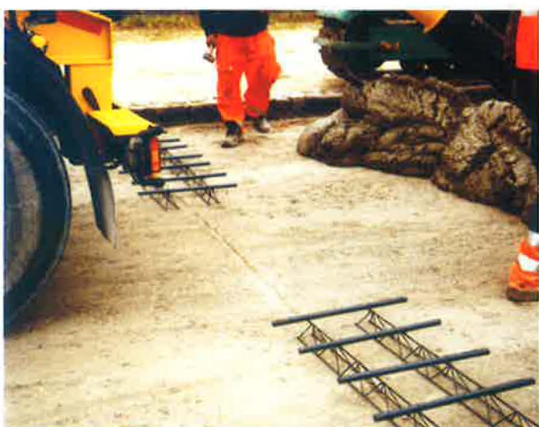
Afb. 28 – Herstelling van een wegdek door vervanging van platen
