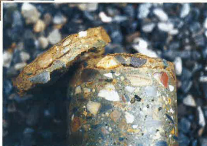
Afb. 10 – Watergreppel waarvan het beton bevroren is in verse toestand en een kern ontnomen uit deze watergoot: onherstelbare schade
