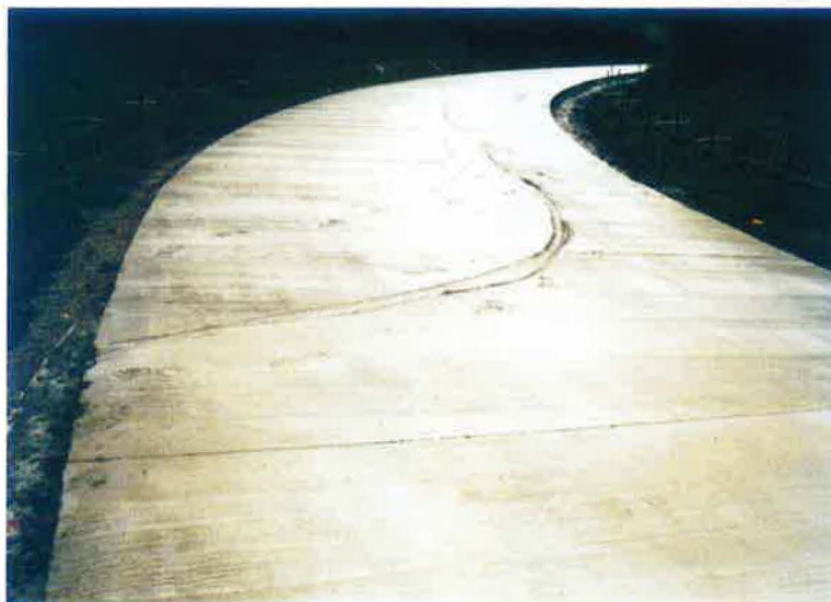
Afb. 21 – Sporen in het verse betonoppervlak
