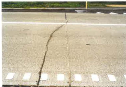
Afb. 13 – Scheurvorming door het blokkeren van de voeg ingevolge slecht geplaatste deuwels of laattijdig zagen
