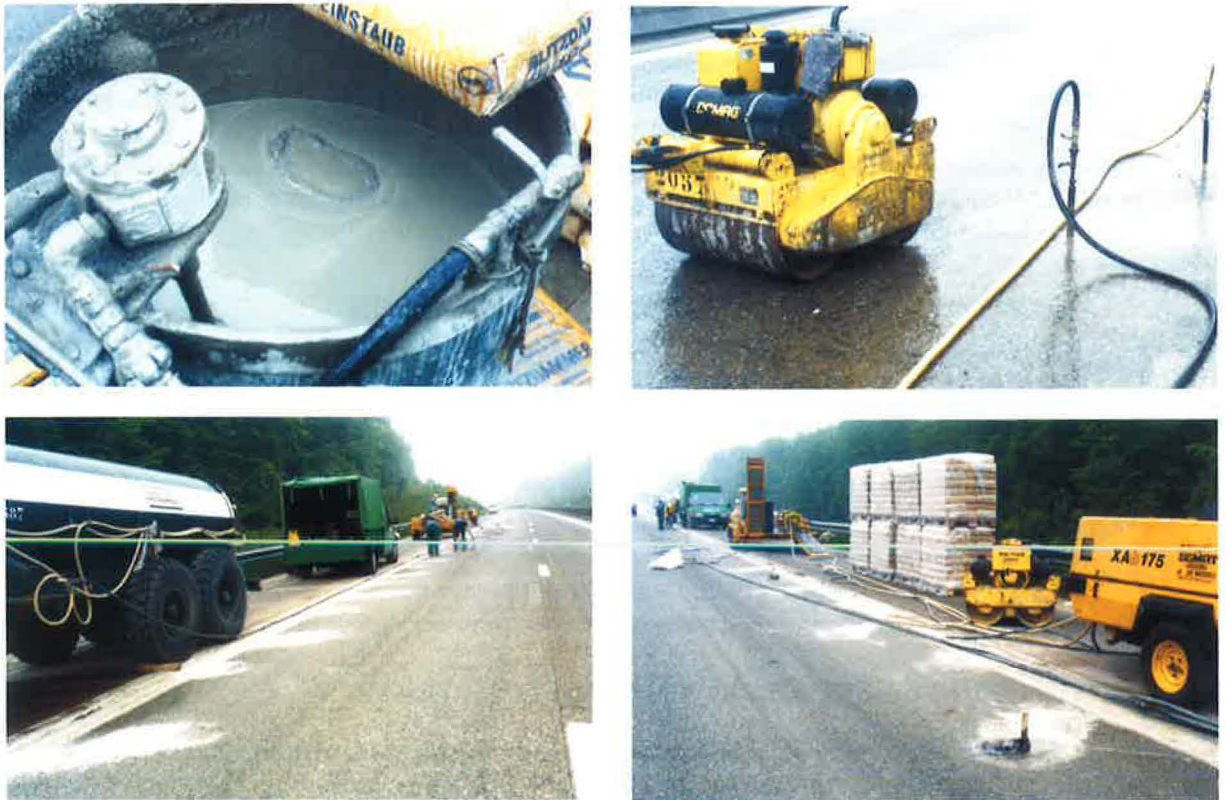
Afb. 47 – Injectie onder een verharding in doorgaand gewapend beton
