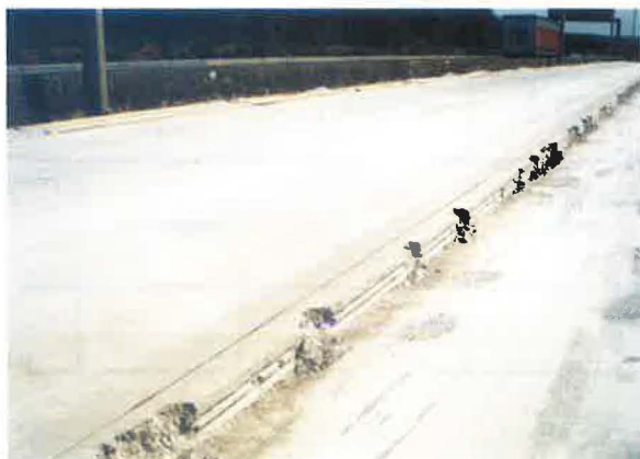
Afb. 7 – Uitzakkingen van de plaatrand door het uitzweten van het beton in verse toestand
