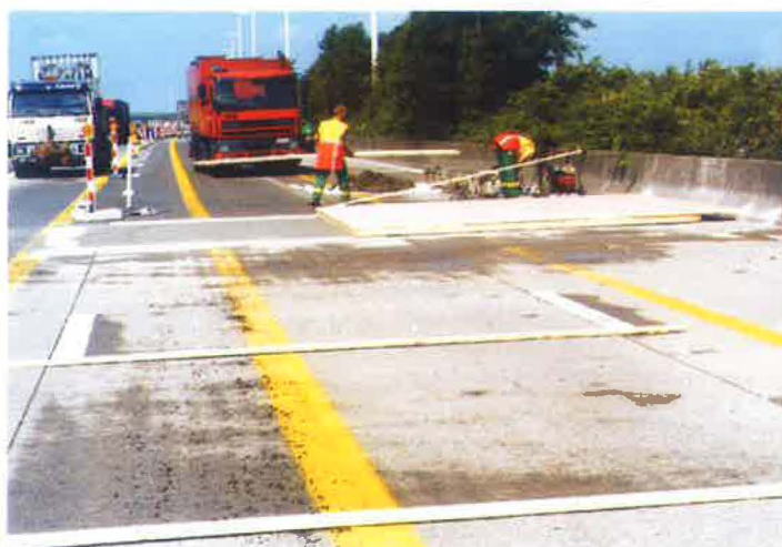
Afb. 38 – Isolatie van de herstelling om de sterkteontwikkeling te bevorderen
