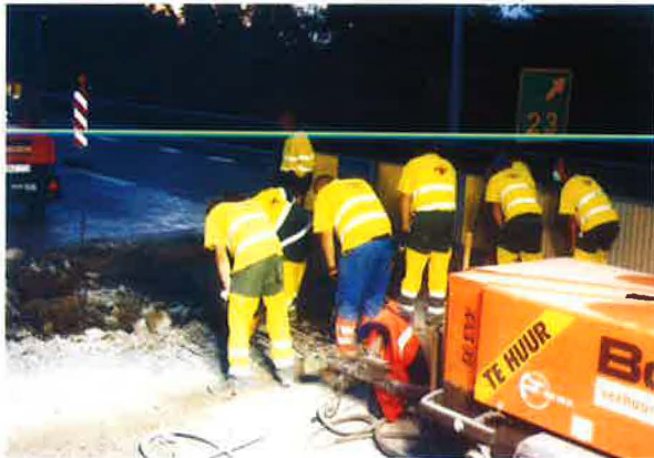
Afb. 32 – Vrijmaken van de langse wapeningsstaven over +/- 1 m aan beide uiteinden van de herstelling. Let op hoe het beton op perfect verticale wijze werd verwijderd onder de gerecupereerde wapening
