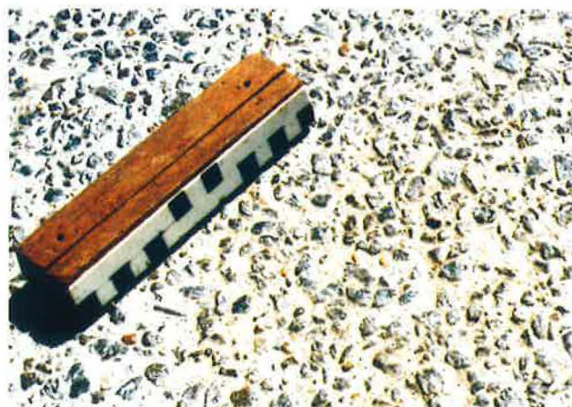
Afb. 49 – Uitzicht van het geluidsarm beton na uitwassen
