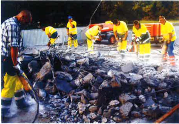
Afb. 31 – Uitbraak ter hoogte van een opstuiking van een weg in doorgaand gewapend beton
