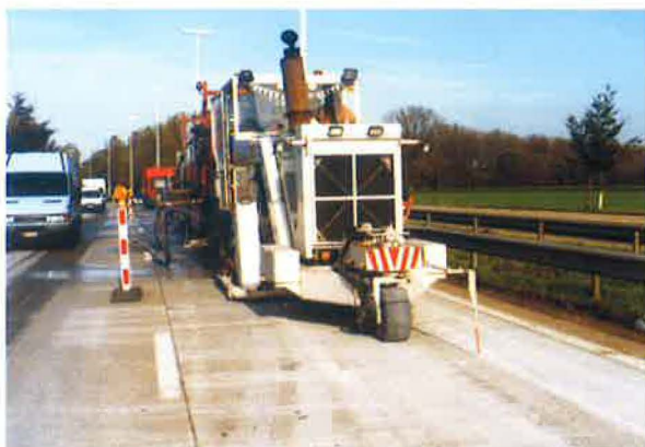
Afb. 50 – Oppervlakbehandeling door afslijpen van een betonverharding
