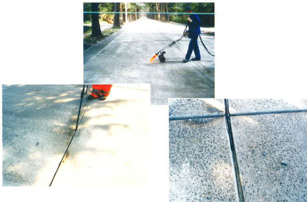
Afb. 24 – Drogen van de sponning en aanbrengen van de voegspecie in een zuivere en droge gleuf
