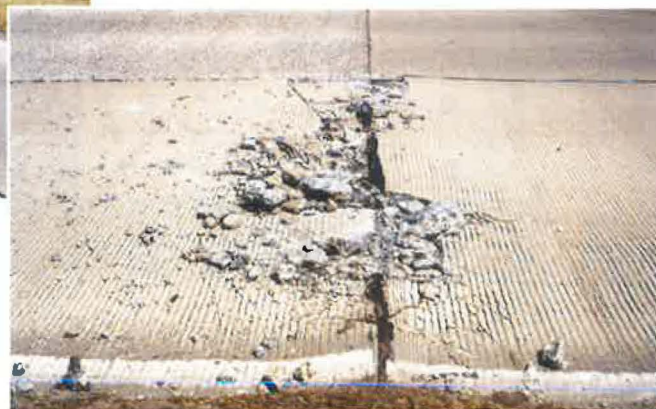
Afb. 4 - Opstuiken van platen door knik in periodes van grote hitte
