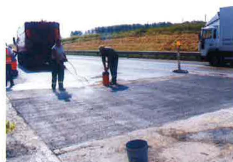
Afb. 37 – Oppervlakbehandeling door bezemen van het verse betonoppervlak en verstuiven van een nabehandelingsproduct
