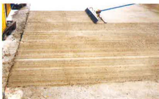
Afb. 37 – Oppervlakbehandeling door bezemen van het verse betonoppervlak en verstuiven van een nabehandelingsproduct
