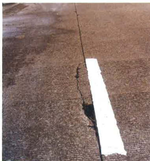
Afb. 16 – Uitbrokkeling langsheen een langsvoeg
