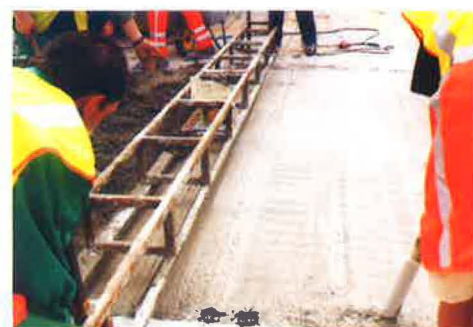
Afb. 36 – Verwerking van het beton met de trilbalk. Langsbeen de zijranden wordt het beton bijkomend verdicht met de trilnaald
