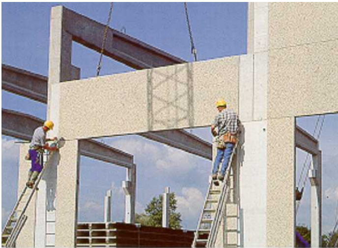
Betonnen gevelpanelen met brandweerstand CF 2h (bron : CIMBETON)
