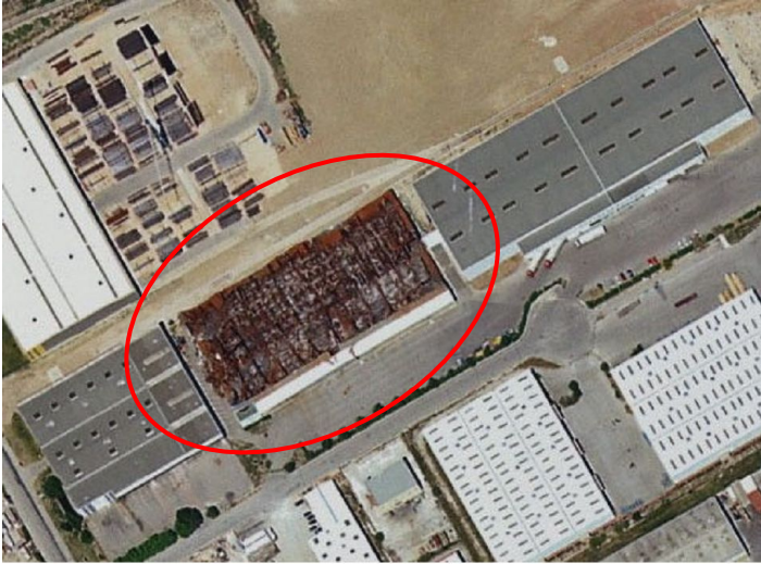
Figuur : een industriële opslagplaats van 7200 m 2 Nord Rognac (Frankrijk) - zaterdag 15 juni 1996 (bron CIMBETON) : De brandmuren in beton hebben perfect de brand geïsoleerd en zijn voortplanting naar naburige opslagplaatsen vermeden.
