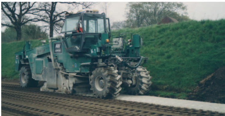
Grondstabilisatie met cement
