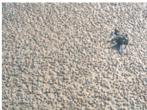
Fijn uitgewassen beton
