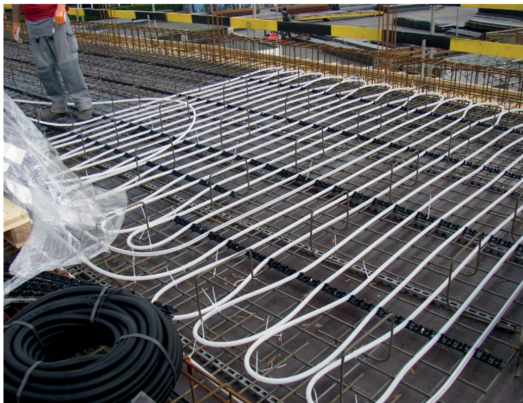
TABS, geïntegreerde thermische activering van betonplaten
