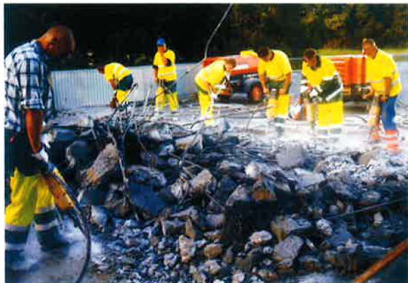
Fig. 31 – Démolition au niveau d'un soulèvement d'un béton armé continu
