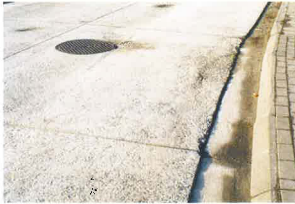
Fig. 9 – Dégâts localisés du béton suite au replâtrage manuel de celui-ci. A remarquer aussi la mauvaise disposition des joints par rapport à l'obstacle fixe
