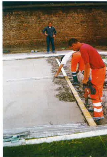
Exécution soignée d'un joint de fin de journée dans le cas d'un revêtement en dalles de béton goujonnées
