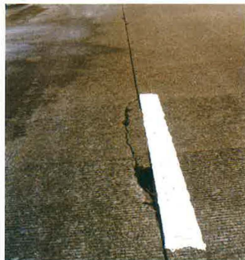
Fig. 16 – Eclatement le long d'un joint longitudinal
