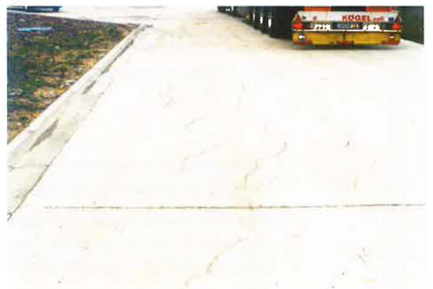
Fig. 8 – Fissures de retrait en phase plastique suite à une protection inefficace du béton contre la dessiccation
