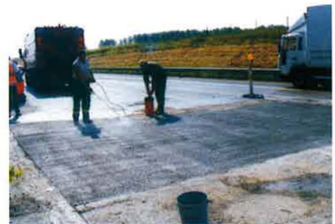
Fig. 37 – Traitement de surface par brosse de la surface du béton frais et pulvérisation d'un produit de cure
