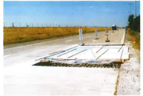
Fig. 35 – Bétonnage d'une réparation longue en plusieurs phases avec réalisation de claveaux, ceux-ci, de part et d'autre d'une zone centrale sont bétonnés au minimum 3 jours plus tard
