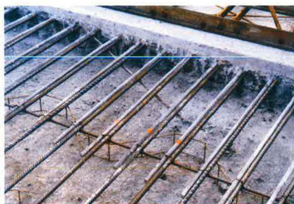
Fig. 32 – Décapage des armatures longitudinales sur \pm 1 m de part et d'autre de la réparation. A remarquer que le béton est démoli de manière parfaitement verticale sous les armatures récupérées
