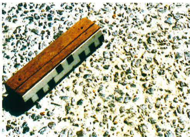
Fig. 49 – Aspect du béton silencieux après dénudage
