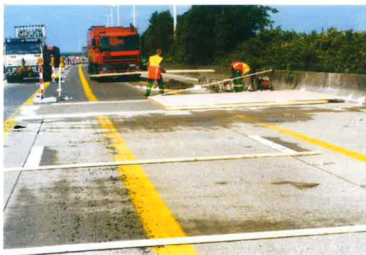
Fig. 38 – Isolation de la réparation afin de favoriser le développement des résistances mécaniques
