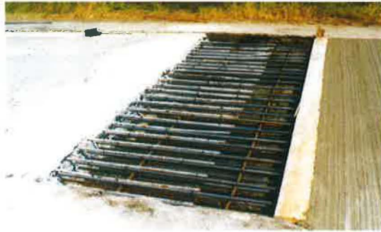
Fig. 35 – Bétonnage d'une réparation longue en plusieurs phases avec réalisation de claveaux, ceux-ci, de part et d'autre d'une zone centrale sont bétonnés au minimum 3 jours plus tard
