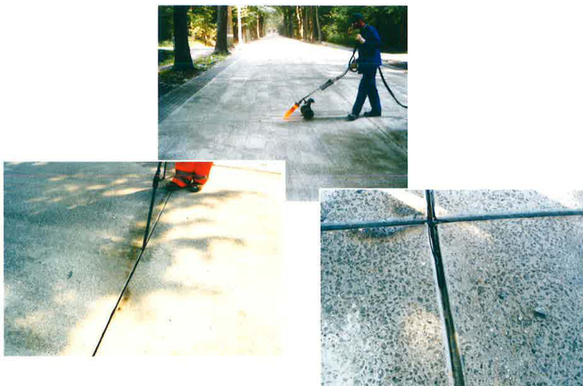
Fig. 24 – Séchage de la gorge de scellement et mise en œuvre du produit dans un orifice propre et sec
