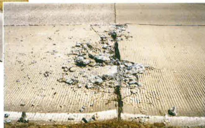
Fig. 4 – Soulèvement de dalles par flambage en période de fortes chaleurs
