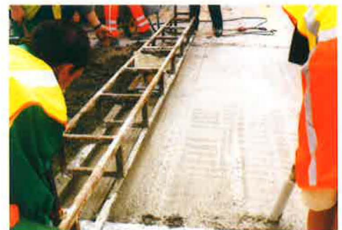
Fig. 36 – Mise en œuvre du béton à la poutre vibrante. Le long des bords, le béton est également compacté à l'aiguille vibrante
