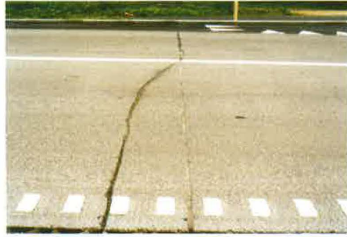
Fig. 13 – Fissuration par blocage du joint suite à des goujons mal placés ou par sciage tardif
