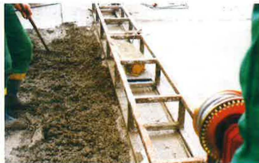
Fig. 36 – Mise en œuvre du béton à la poutre vibrante. Le long des bords, le béton est également compacté à l'aiguille vibrante
