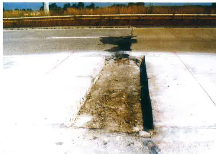
Fig. 29 – Réparation au niveau d'un joint de construction.
