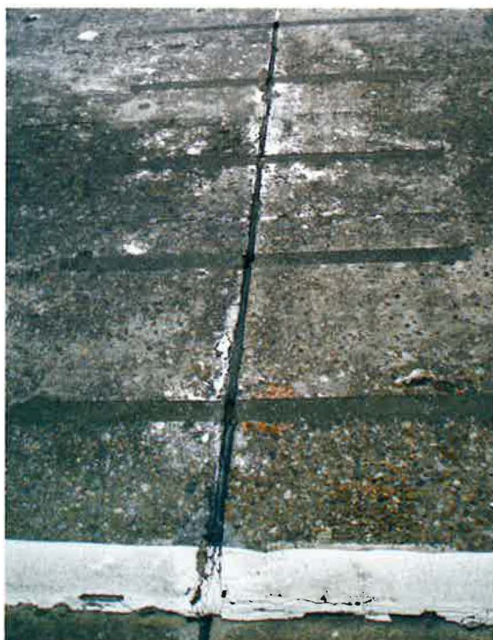
Fig. 26 - Joint transversal où le transfert des charges a été établi par insertion de goujons dans le béton durci
