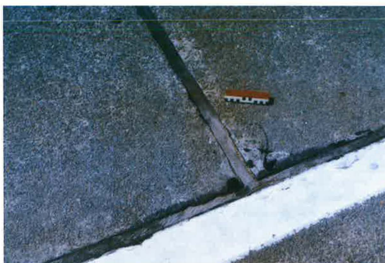
Fig. 20 – Nouveau scellement des joints d'une ancienne route en béton
