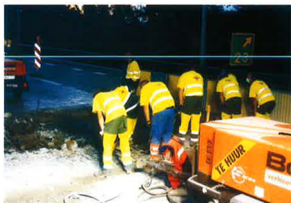
Fig. 32 – Décapage des armatures longitudinales sur \pm 1 m de part et d'autre de la réparation. A remarquer que le béton est démoli de manière parfaitement verticale sous les armatures récupérées
