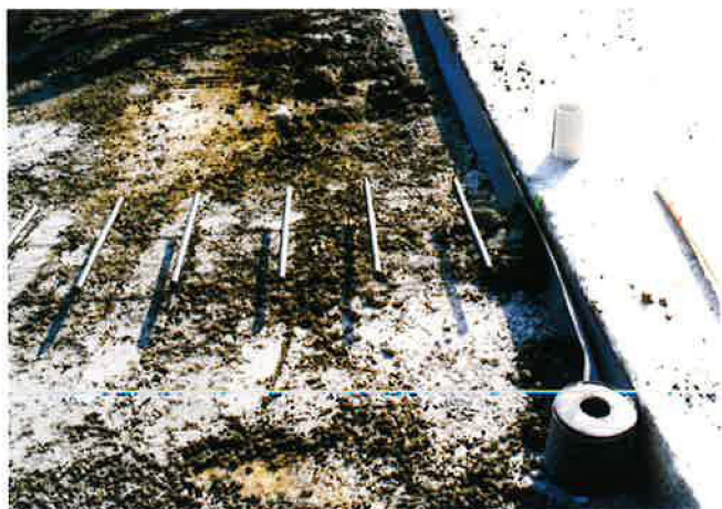
Fig. 51 – Bande de roofing déroulée contre la paroi verticale constituée par un ancien béton (qui sera maintenu) afin d'éviter des fissures de sympathie dans une réparation
