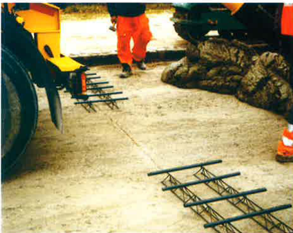
Fig. 28 – Réparation d'un revêtement par remplacement de dalles
