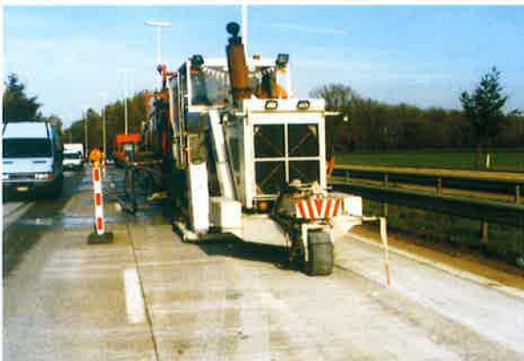
Fig. 50 – Traitement de surface par meulage d'un revêtement en béton
