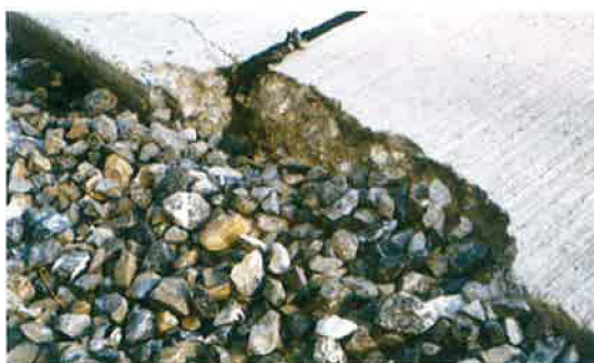
Fig. 12 – Eclatement du béton aux abords d'un joint de dilatation dû au fait que la fourrure ne s'étendait pas jusqu'au bord du revêtement
