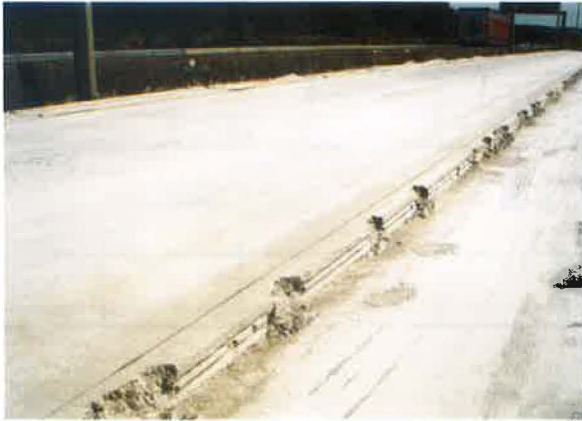
Fig. 7 – Affaissement du bord de dalle par ressuyage du béton à l'état frais
