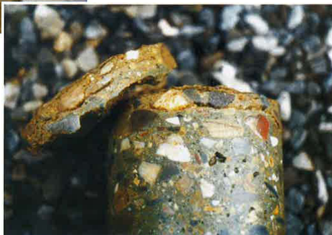
Fig. 10 – Filet d'eau dont le béton a gelé à l'état frais et carotte extraite de ce filet d'eau : dégâts irrécupérables
