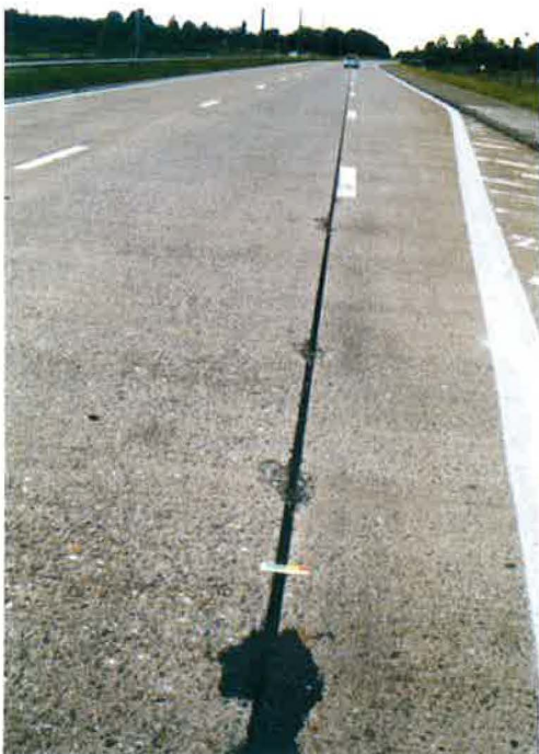
Fig. 15 – Joint longitudinal ouvert
