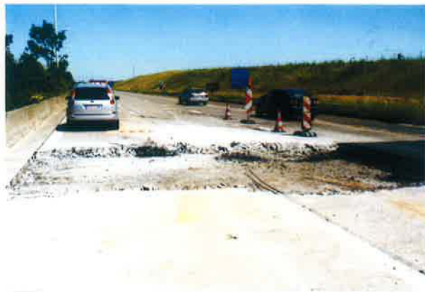
Fig. 31 – Démolition au niveau d'un soulèvement d'un béton armé continu
