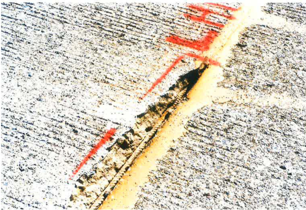
Fig. 45 – Eclats de béton pouvant être réparé au moyen d'un liant hydraulique modifié ou d'un liant résineux
