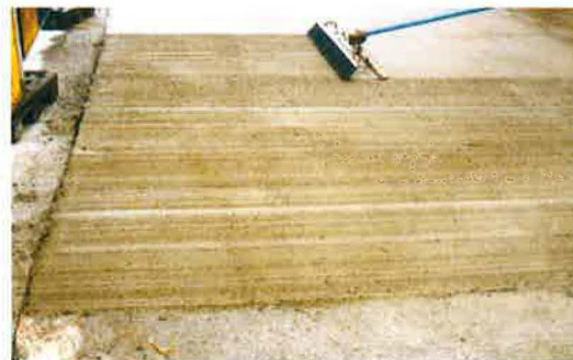
Fig. 37 – Traitement de surface par brosse de la surface du béton frais et pulvérisation d'un produit de cure
