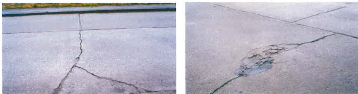
Fig. 18 – Exemple de fissure dans un revêtement ancien (joint décalé – fissure de sympathie) et exemple d'évolution d'une fissure (épaufrures et désagrégation des lèvres)
