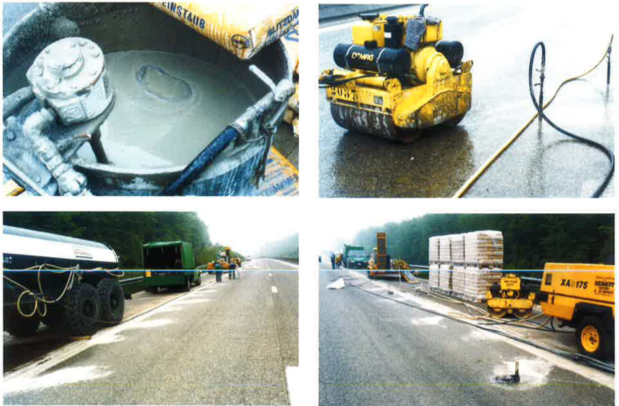
Fig. 47 – Injection sous un revêtement en béton armé continu
