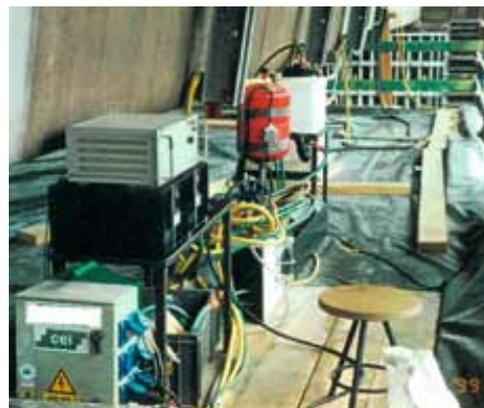
Figure 3 : Injection de la solution inhibitrice au moyen du transducteur ultrasonore<sup>3</sup>
