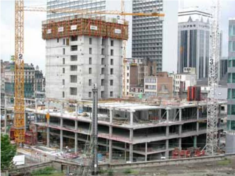
Figure 5 : Noyau central exécuté en coffrage grimpant<sup>10</sup>
