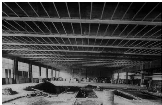
Figure 7 : Poutres pour toiture de hangar à l'aéroport de Melsbroek<sup>1</sup>
