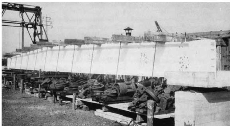
Figure 7 : Essai d'une poutre précontrainte à Francfort (1933-1934)<sup>6</sup>
