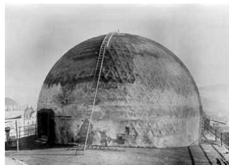
de construction Dyckerhoff et Widmann de Wiesbaden qui propose de projeter du béton gunité à travers l'ossature métallique sur un coffrage mobile en bois de 3 m par 3 m. Le prototype qui est réalisé est un dôme en béton de 16 m de diamètre et de 3 cm d'épaisseur, dont l'armature est principalement constituée du treillis métallique, construit sur le toit de l'usine Zeiss à Iéna en 1922-1923 (Fig. 1).
