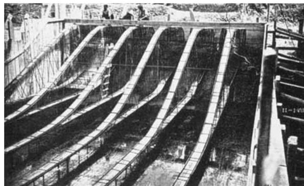
contreforts du barrage supportent le tablier d'un pont de service réalisé (1937-1939) avec des poutres précontraintes à fils adhérents de 20 m de portée.
