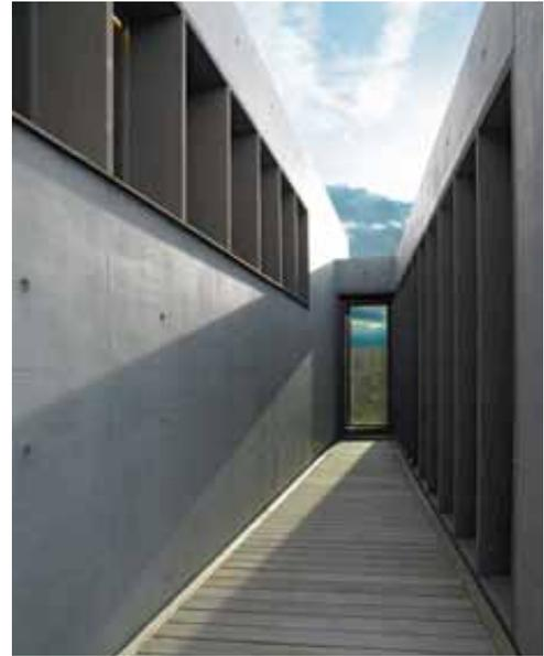
mur ont été coulés un à un. Aux angles, les panneaux de coffrage ont été placés dans la prolongation du mur à bétonner. Les cages d'armatures et l'isolation formaient l'angle du mur. Au-delà de l'angle, le coffrage du mur suivant se connectait au précédent (Fig. 8).
