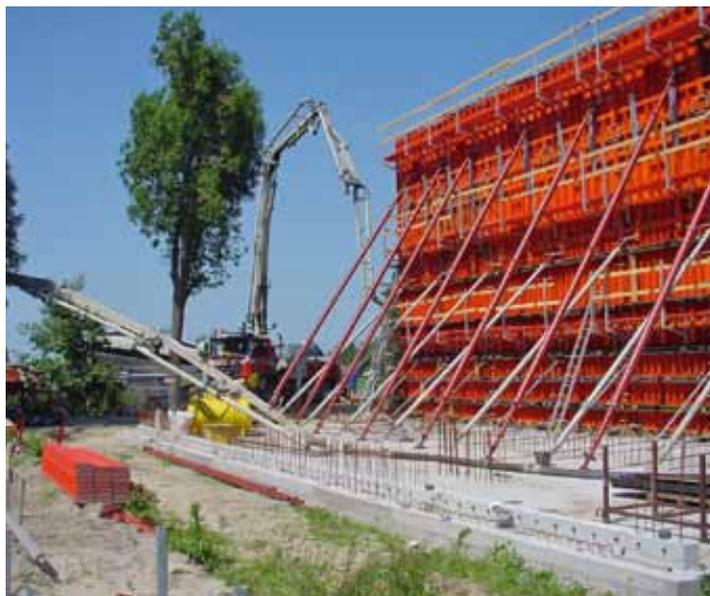
Figure 4b : Mur en cours de bétonnage<sup>3</sup>
