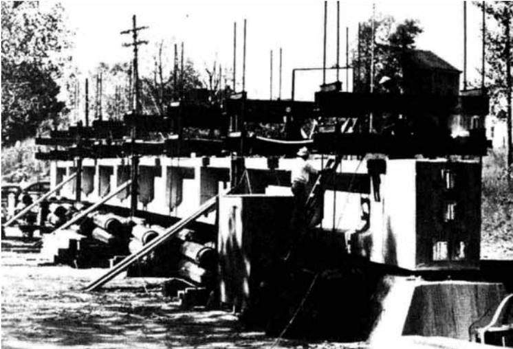
Figure 12 : Essai de chargement d'une poutre du Pont de la Walnut Lane<sup>1</sup>
