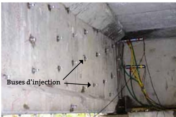
Figure 2 : Après perçage et mise en place des buses d'injection<sup>2</sup>
