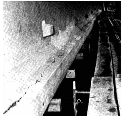
une adaptation hybride de la poutre standard AASHTO Type V, furent toutes préfabriquées dans une usine certifiée PCI, alors qu'en 1949, les poutres avaient été fabriquées et précontraintes par post-tensioning sur le chantier.
