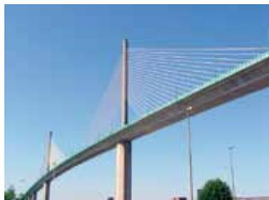
procure une étanchéité parfaite des parois de béton. De plus, l'utilisation d'une post-tension adaptée spécifiquement à la méthode de construction a permis de réaliser la structure à une extrémité du site et à la mettre en place par une opération de ripage longitudinal par poussage dont la masse (65 000 tonnes) mise en mouvement à cette occasion lui vaut de détenir le record du monde de la méthode.
