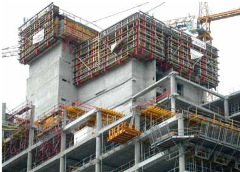
Figure 6 : Ossature préfabriquée en béton armé et précontraint<sup>10</sup>
