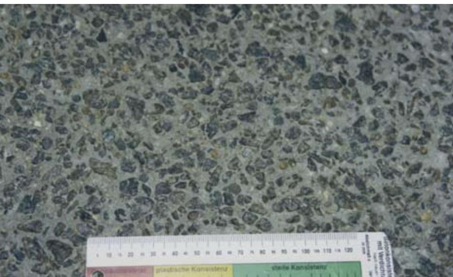
Figure 19 – Le dénudage est une opération qui consiste à éliminer le mortier superficiel du revêtement pour laisser apparaître les gravillons en surface. Ce traitement est pratiquement le seul à être utilisé en Belgique pour les autoroutes et les routes importantes en raison du faible bruit de roulement qu'il occasionne
