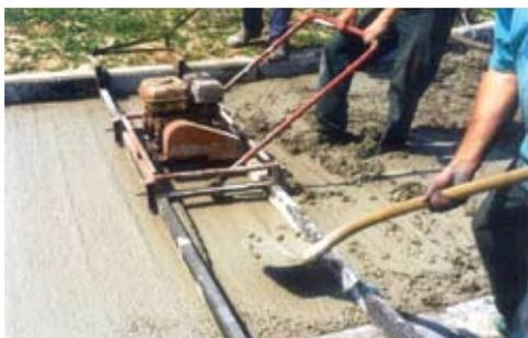
Figure 44 – Compactage d'un béton destiné à être imprimé
