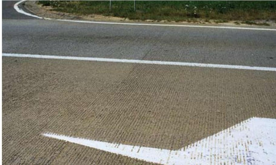
Figure 20 – Le striage transversal ou rainurage est obtenu à l'aide de râteliers dont les dents, en plastique ou en acier, sont distantes de 20 à 50 mm. La profondeur des stries est de 2 à 3 mm. Ce type de traitement a été beaucoup utilisé sur les routes à trafic important pour être ensuite abandonné en raison de l'inconfort acoustique et de roulement qu'il peut provoquer
