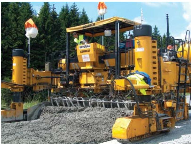
Figure 25 – Réhabilitation des autoroutes E411 et E25 en province de Luxembourg au moyen d'un béton armé continu 0/32
