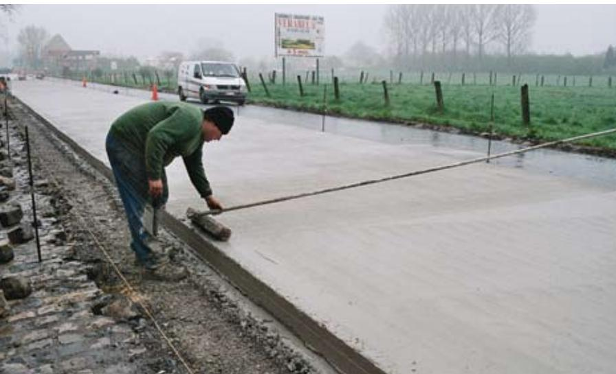
Figure 18 – Le brossage de la surface du béton est réalisé en appliquant transversalement sur le béton frais une brosse dure à fibres jointives. La micro-texture ainsi obtenue est d'autant plus durable que la qualité du mortier est excellente (sable – ciment – eau – protection)
