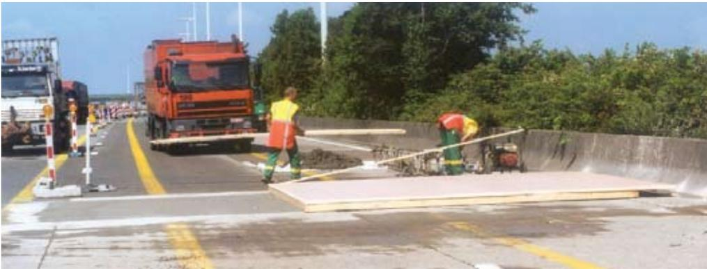
Figure 46 – Afin d'accélérer le développement des résistances mécaniques à court terme, le béton de réparation est, après sa mise en œuvre, immédiatement protégé contre la dessiccation par la pulvérisation d'un produit de cure et ensuite isolé au moyen d'un matelas de polystyrène expansé de minimum 5 cm d'épaisseur
