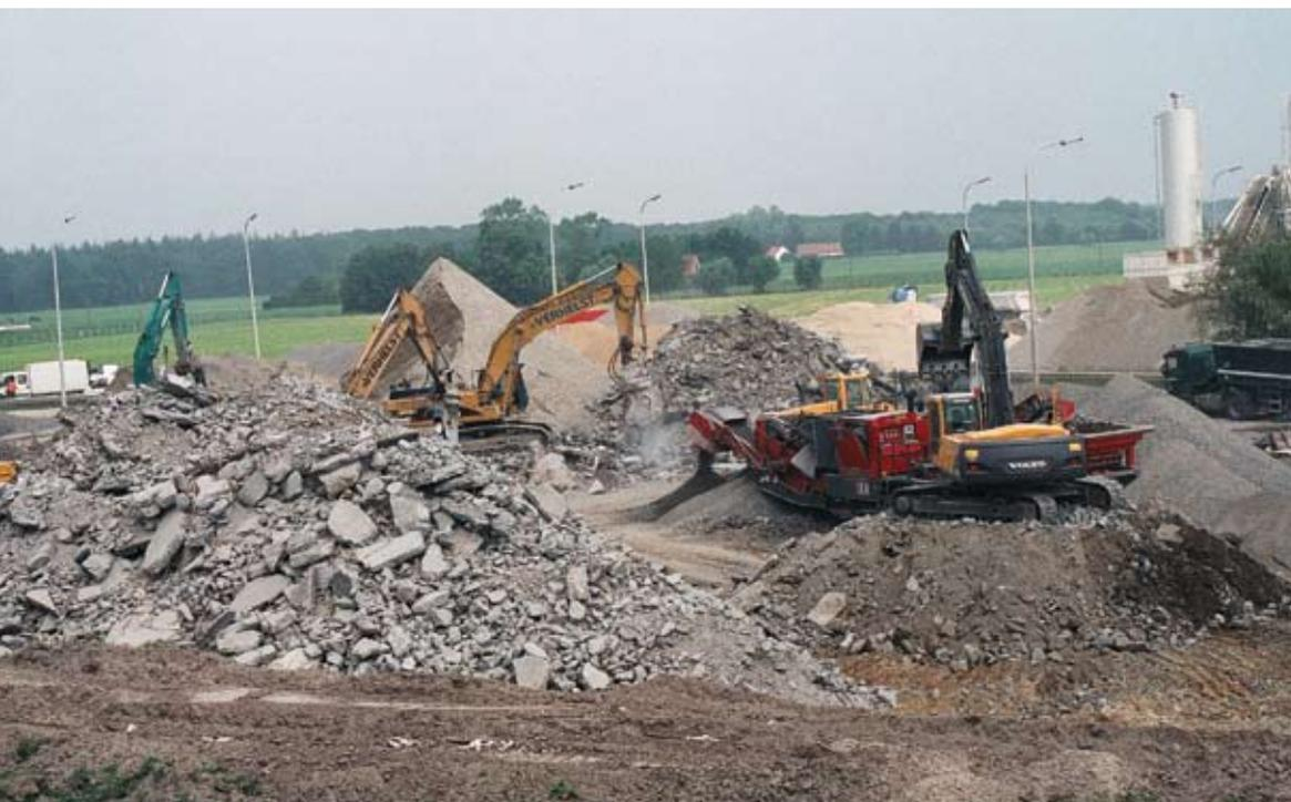
Figure 51 – Les produits issus de la démolition sélective de revêtements en béton sont recyclables. Le moteur économique mais aussi la pression environnementale plaident aujourd'hui pour une utilisation plus noble qu'uniquement en fondation
