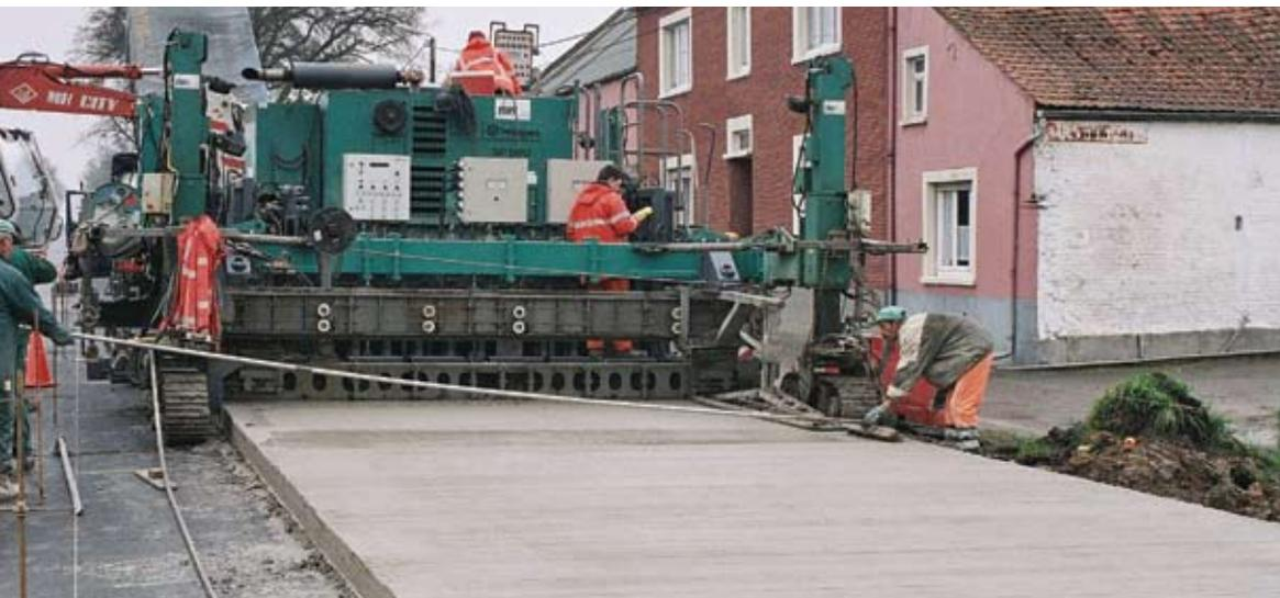
Figure 27 – Travaux de bétonnage de la N29 à Perwez. La chaussée est constituée d'un revêtement en dalles de béton goudonnées dont le traitement de surface est un broyage
