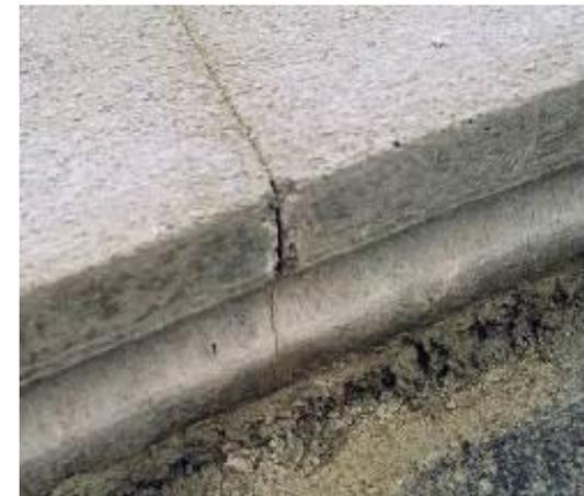
*Joint longitudinal de construction
