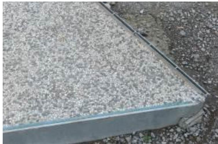
*Profilé en acier galvanisé fabriqué sur mesure, joint de construction (Herstal, Pôle Marexhe)*
