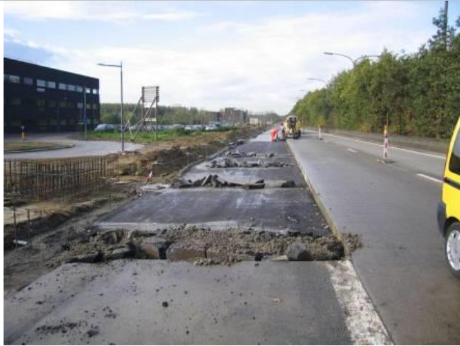
Uitgraving van 4 verankeringsribben
