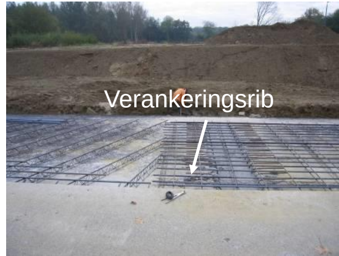
Overgang schuine naar loodrechte schikking dwarswapening + verdubbeling langswapening
