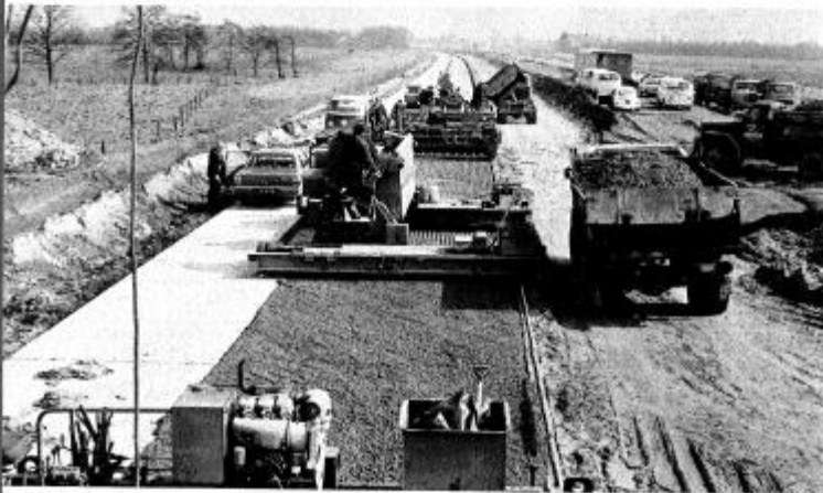
Doorgaande wapening voor een doorgaand gewapende betoning in België. foto: G.Coolens, Antwerpen
