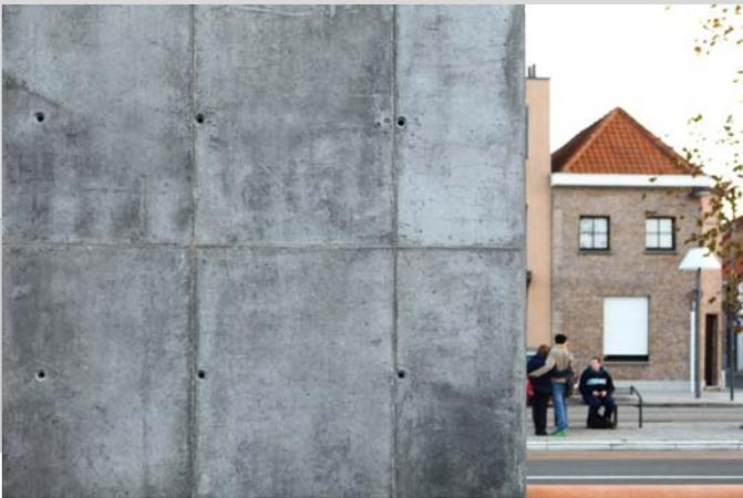
Les volumes d'accès au parking sont eux aussi en béton coulé en place, de teinte gris foncé. Le calepinage et les marbrures à la surface du béton donne un aspect vivant au matériau.
