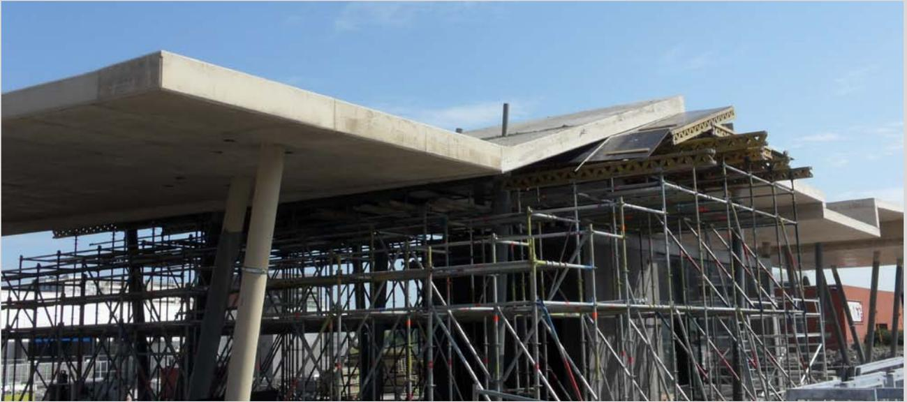
Dominant la place, une grande toiture se développe au centre de l'espace public. Elle est constituée d'une série de hautes colonnes inclinées supportant un important voile en béton apparent plié de façon aléatoire, comme déformé sous l'effet du vent. Le tout a été coulé sur place à l'aide d'un impressionnant coffrage.
