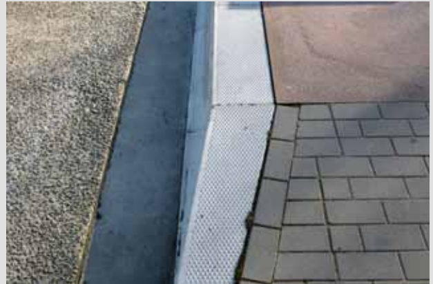
Au parking 'Demervallei', un arrêt de bus a été aménagé avec des dalles de quai préfabriquées en béton et des bordures blanches adaptées. L'ensemble est agrémenté de mobilier urbain moderne en béton.
