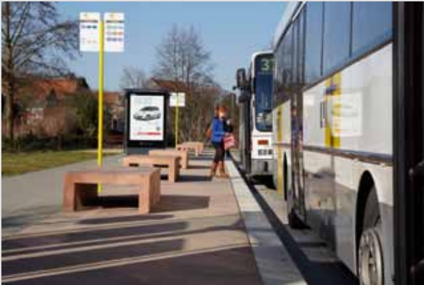
Au parking 'Demervallei', un arrêt de bus a été aménagé avec des dalles de quai préfabriquées en béton et des bordures blanches adaptées. L'ensemble est agrémenté de mobilier urbain moderne en béton.
