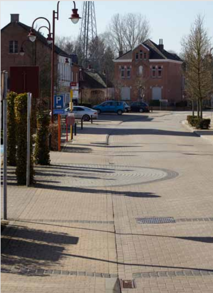
La traversée de la commune de Wolfsdonk a été rénovée à la fin des années 1990 : les pavés en béton ont été choisis non seulement pour les trottoirs et les pistes cyclables, les squares et les parkings, mais aussi pour la chaussée : le passage de poids lourds est rare dans le centre.
