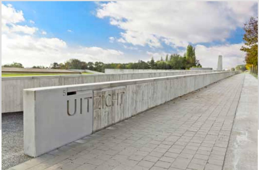
Une série d'éléments en béton préfabriqués et très lisses contrastent avec le béton structuré et ponctuent l'ensemble du bâtiment pour en marquer les endroits particuliers, tel que l'entrée.
