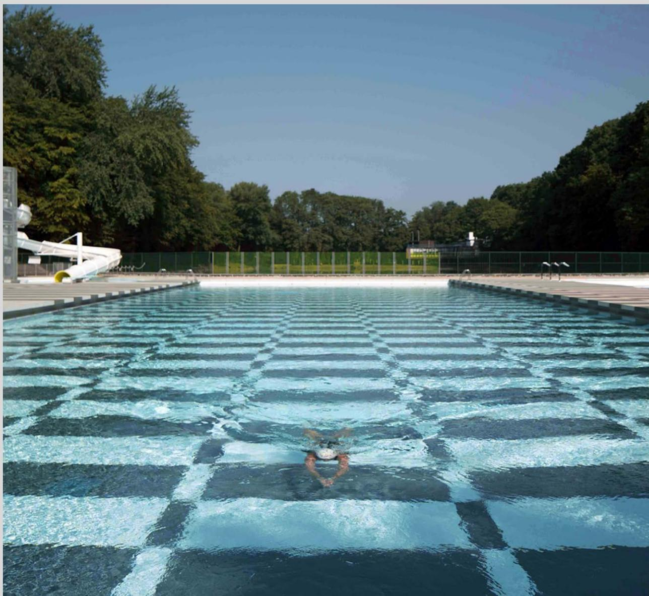
Les dalles en béton préfabriquées ont été réalisées sur mesure pour s'accorder aux dimensions du bassin et de ses couloirs de natation.
