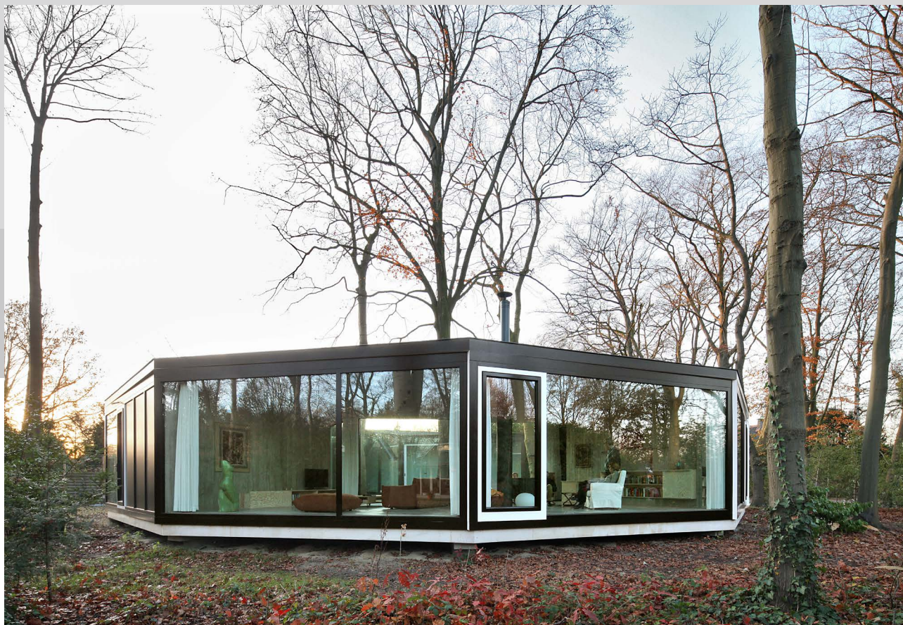
La maison présente une volumétrie circulaire percée d'un large patio. Cette implantation permet de préserver la totalité des arbres remarquables de la parcelle. La position des pieux de fondation est ajustée au cas par cas afin de ne pas abîmer les racines.
