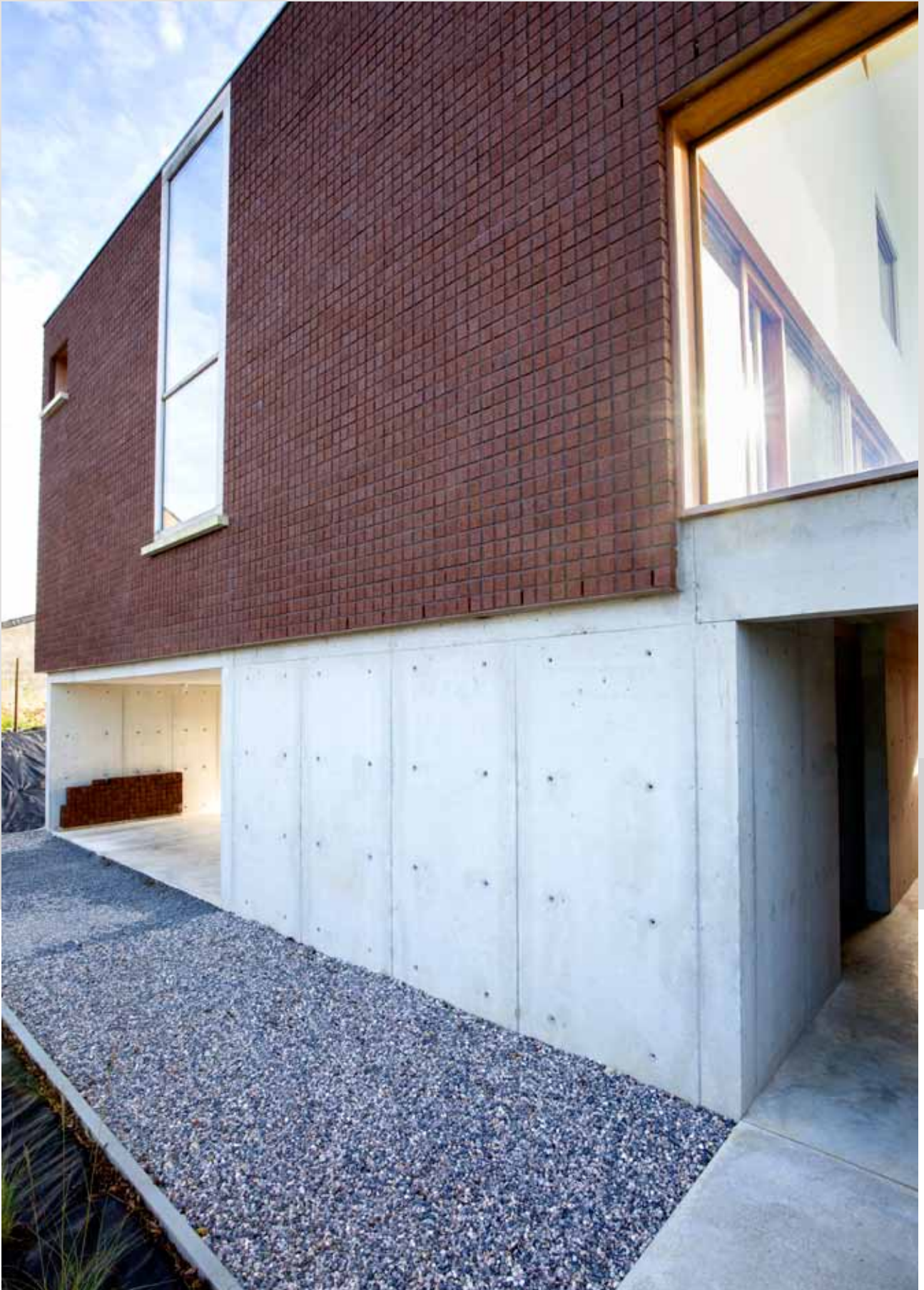
Les matériaux employés sont une interprétation du vocabulaire architectural régional. Les voiles de béton font écho aux soubassements de pierre calcaire, tandis que le parement en briques carrées s'inspire des tomettes et des maçonneries en brique employées dans les fermes voisines.
