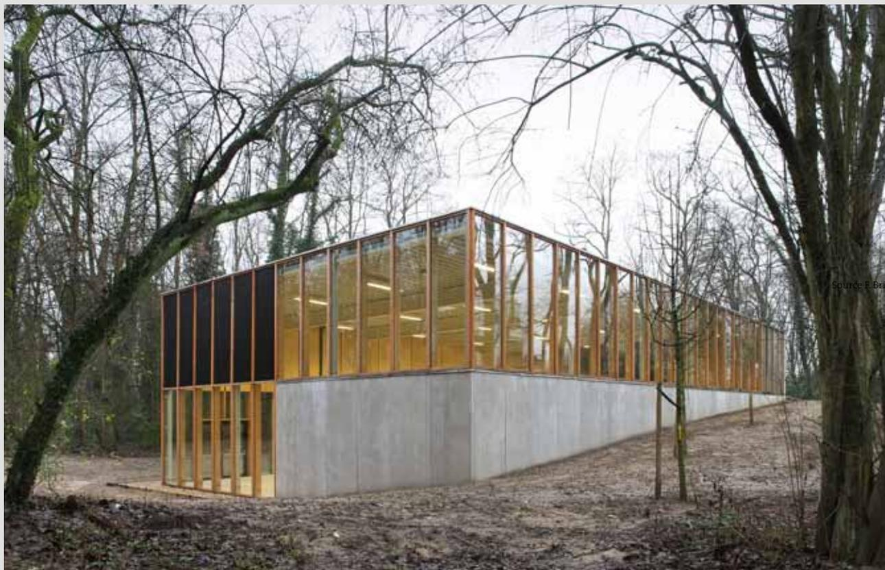
Le bâtiment s'implante dans le talus. Un socle en prémurs isolés en béton a été réalisé. Il sert de base à la structure en bois, tout en assurant l'étanchéité à l'eau de cette partie de bâtiment enterrée. Au bout du volume, la façade exprime parfaitement le parti architectural qui joue avec la transparence, la lumière et les notions de lourd et de léger.
