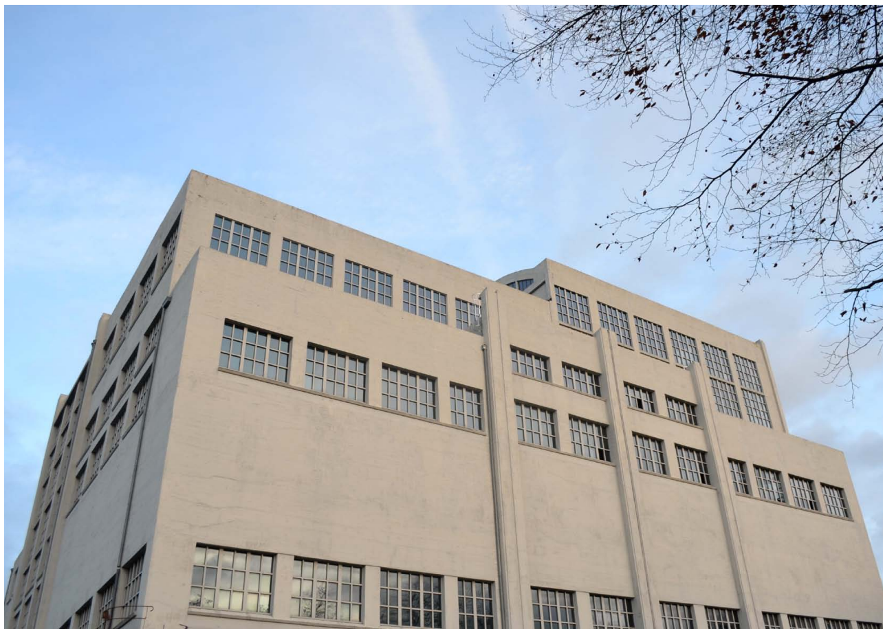
Le Triage-lavoir, à l'entrée de la Ville de Binche est un bâtiment imposant, une structure faite pour résister au temps. Les dimensionnements de sa structure ont été calculés avec un coefficient d'impact allant jusqu'à 5. La stabilité d'ensemble reste donc largement assurée.
