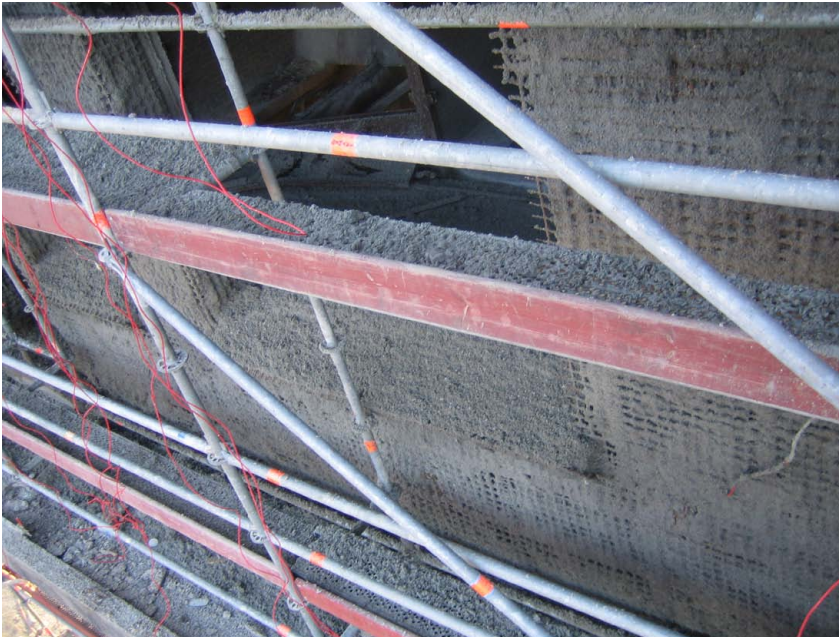
Traitement en cours.
