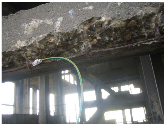
Raccord d'une cathode.
