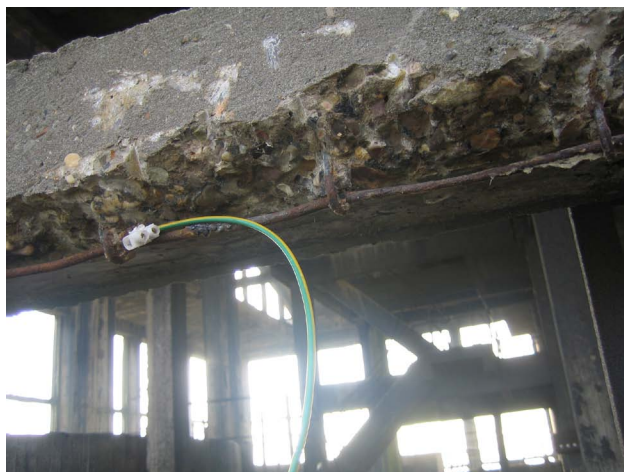
Aansluiting van een kathode.
