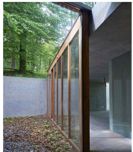
A l'intérieur, le béton-vo est utilisé pour les dalles de sol, le plafond et certains murs. Le reste des éléments structurant l'espace est blanc (murs plâtrés et mobilier encastré). Leur surface lisse met en valeur l'aspect brut du béton.
