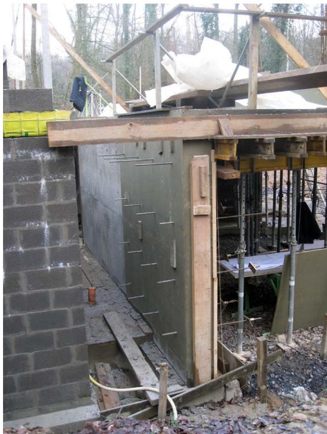
La précision du calepinage, des arêtes vives et des joints de reprise est le fruit du travail rigoureux et fastidieux du coffrage, réalisé sur mesure. L'entrepreneur estime avoir passé deux fois plus de temps pour sa mise en œuvre. Chaque détail a longuement été étudié et chaque panneau n'a été utilisé qu'une seule fois.
