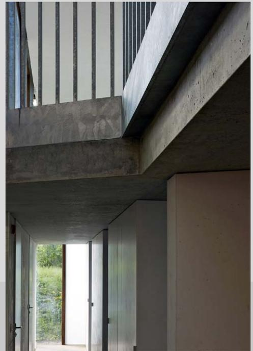
L'utilisation du béton étant à la base du projet, l'architecte a voulu en conserver l'omniprésence malgré les divers remaniements du projet. Grâce au jeu de fins décalages entre la structure et sa peau en bardeaux de cèdre, le squelette en béton est ainsi toujours présent à la vue, que ce soit par les larges voiles ou par les apparitions ça-et-là de tranches de béton, visibles sous le bardage de cèdre, à travers les châssis, etc
