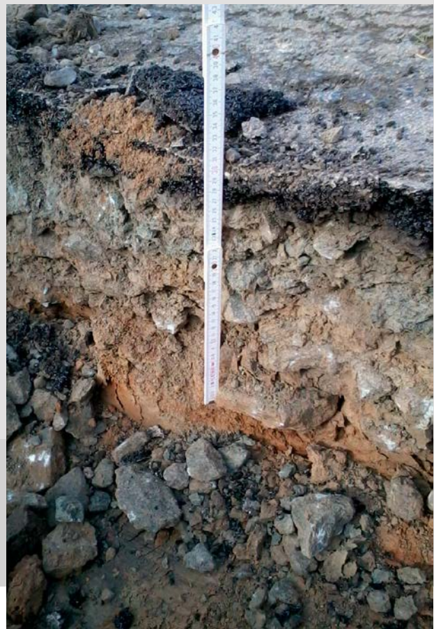
Sondering van de bestaande toestand vóór de werken
