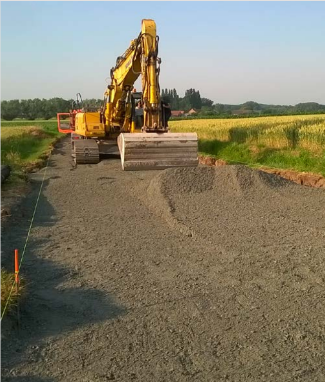
Aanleg van de fundering
