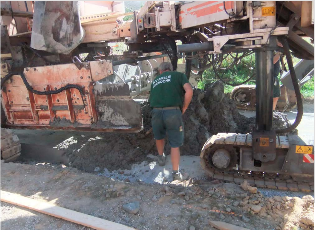
Aanleg van de rijweg in beton met de glijbekistingmachine.
