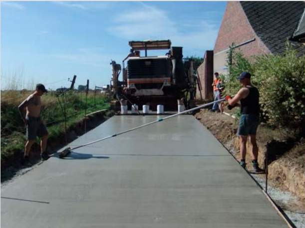
Afwerken van het oppervlak door middel van een dwarse bezemstreek
