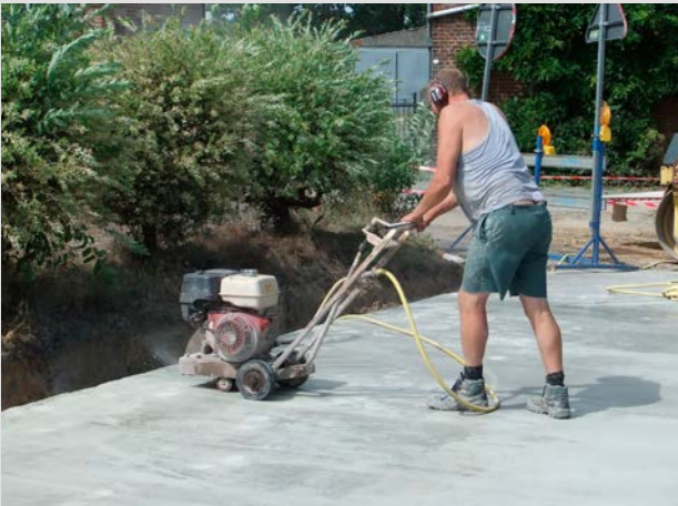
Zagen van de dwarse krimpvoegen. Omwille van het warme weer gebeurde dit al een zestal uur na betonneren.
