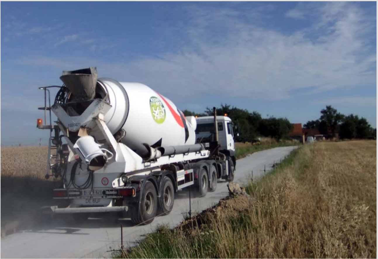
Door de beperkte manoeuvreerruimte was de aanvoer van het wegebeton met truckmixers een heel huzarenstuk
