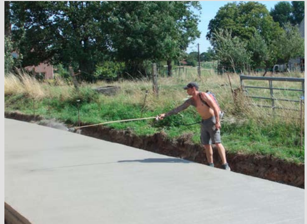
Bescherming van het verse beton tegen uitdroging door het verstuiwen van een nabehandelsproduct (curing compound)
