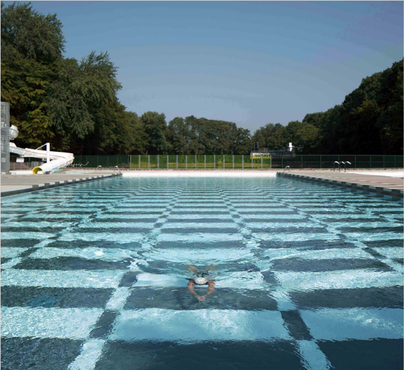
De vloerelementen werden op maat uitgevoerd om te kloppen met de afmetingen van het bad en van de zwembanen.
