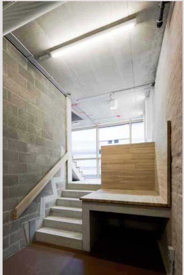
Op meerdere plaatsen in het project hebben de architecten het plastische karakter van beton verder doorgedreven. Beton speelt het spel mee en leent zich tot creaties van bijzondere "plekjes" zoals een dubbele trap/podium onder de voetplaat van een trap, om de try-outsessies te kunnen volgen, of een specifiek tablet voor de confectie van pruiken.
