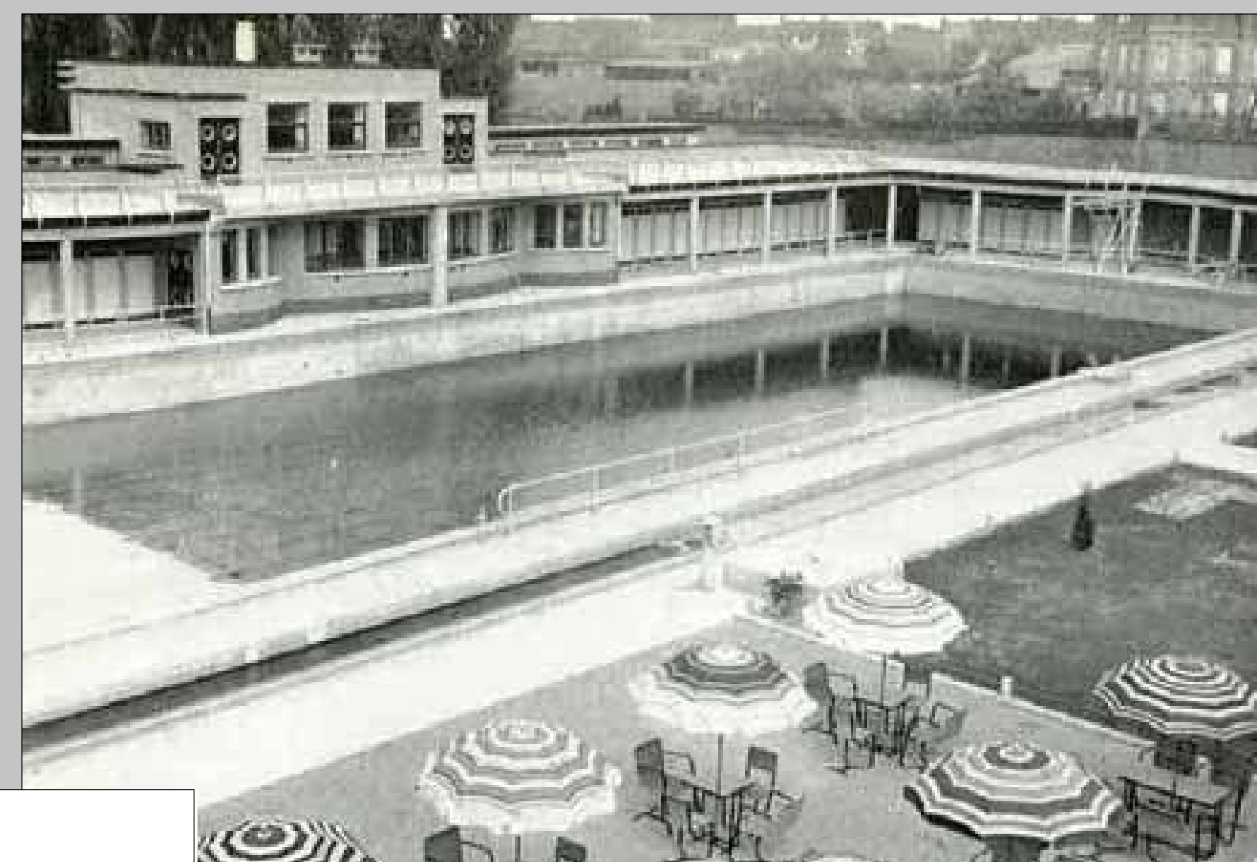
Fig. 1. — Bassin de natation de la ville de Menin. Ce bassin est revêtu d'une chape d'étonné de 22 mm à base de mortier de ciment comportant des adjuvants hydrofuges.
