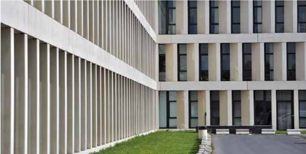
AZ Groeninge - Arch. Baumschlager&Eberle © Diathèque febe
