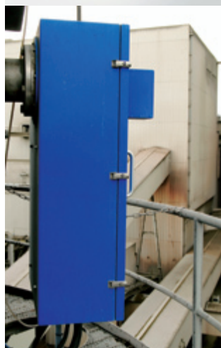
Controlesysteem voor het gas in de schouw.
