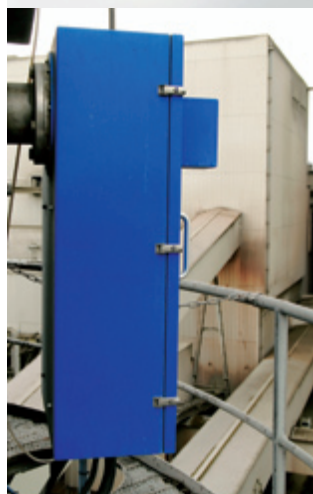
Système de contrôle des gaz à la cheminée.
