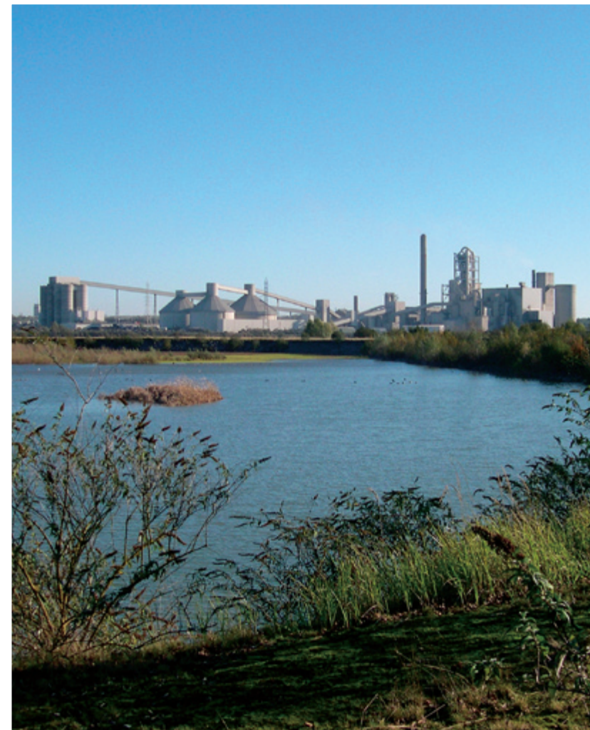
Bassin de décantation de Béthomé (CCB).
