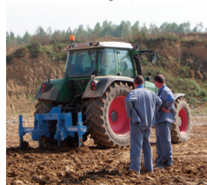
Réaménagement agricole de la carrière du Romont (CBR) : décompactage des terres réaménagées avec du matériel agricole.
