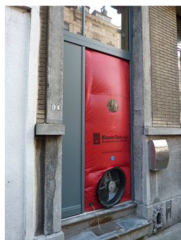
Blower-door test et repérage des désordres dans l'isolation d'une toiture
