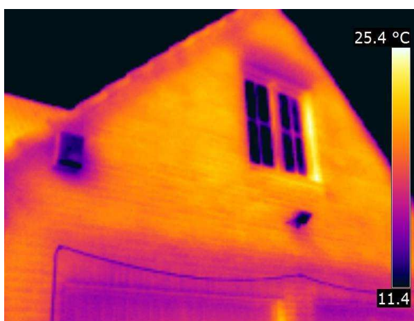
Aanzienlijke warmteverliezen ter hoogte van de lateien, met gevaar voor condensatie
