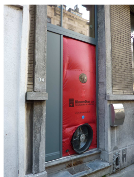
Blower-door test en visualisering van gebreken in de dakisolatie
