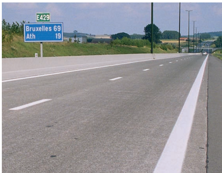
Step-profiel langs de autosnelweg A8 Brussel-Doornik
