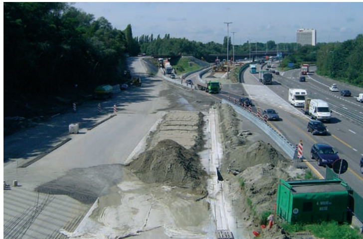
Dichter zicht op de isolerende zandlaag die de beweging van het DGB aan de uiteinden voorkomt
