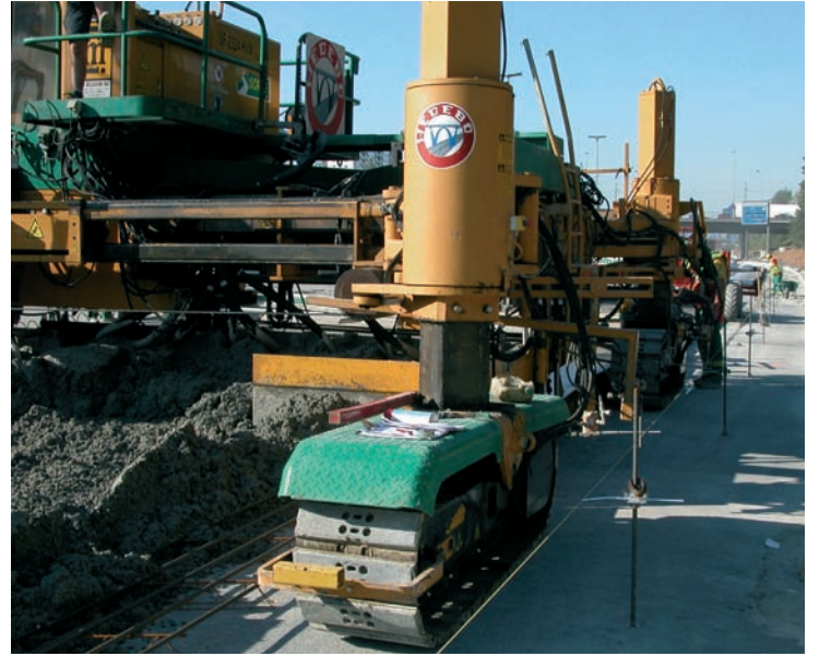
De slipform paver werd gestuurd door geleidedraden
