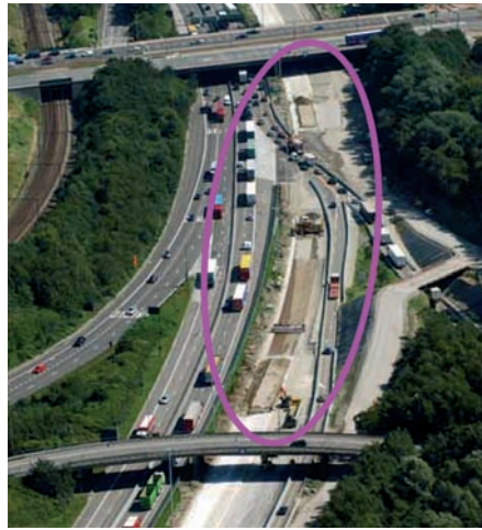
Algemeen zicht op een onderbreking in het DGB met een isolerende zandlaag op de uiteinden
