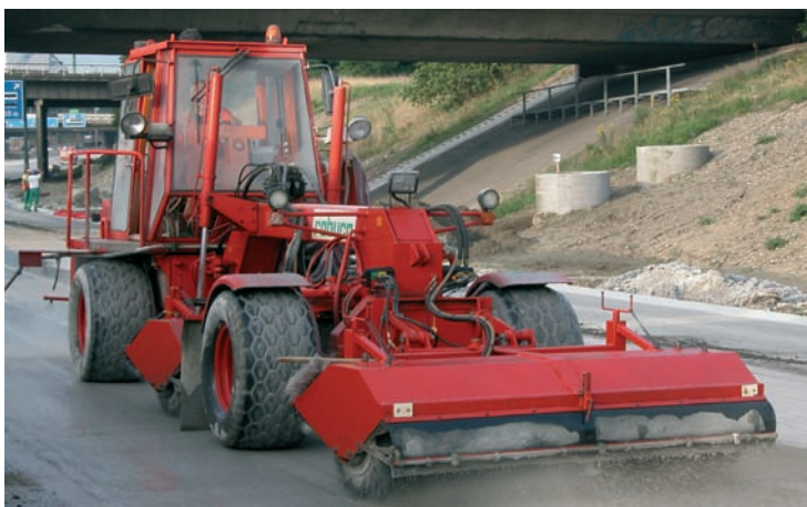
Verwijderen van de mortel aan het oppervlak door borstelen
