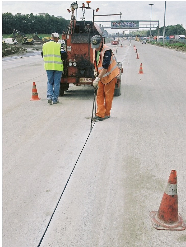
Dichten van de langsvoeg met warme voegvullingsmassa
