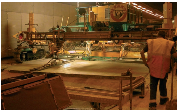
Betonneren in de Kennedytunnel
