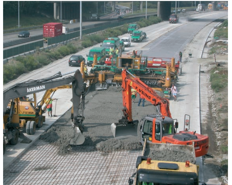
Algemeen zicht op de betonneringstrein
