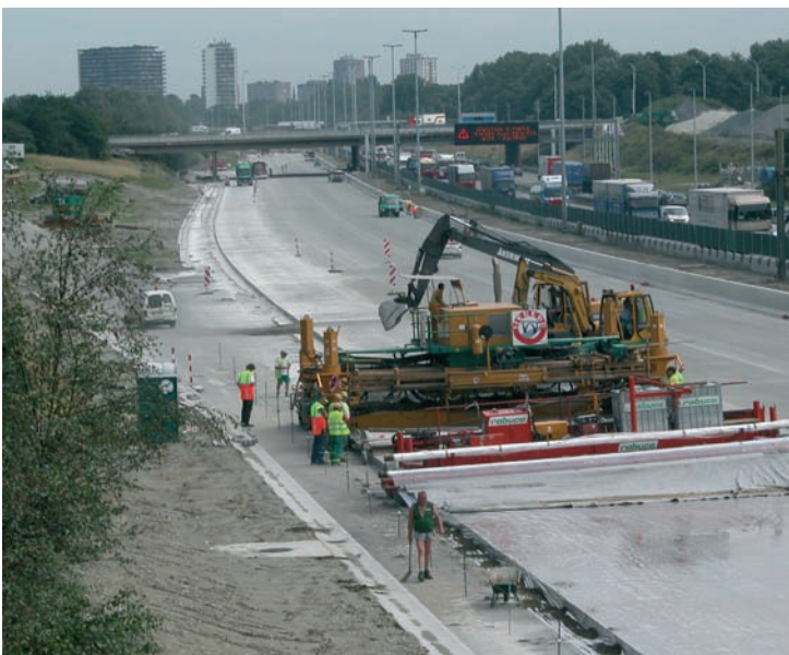
Zicht op de glijbekistingsmachine en de extra manuele verdichting van het beton langsheen de randen
