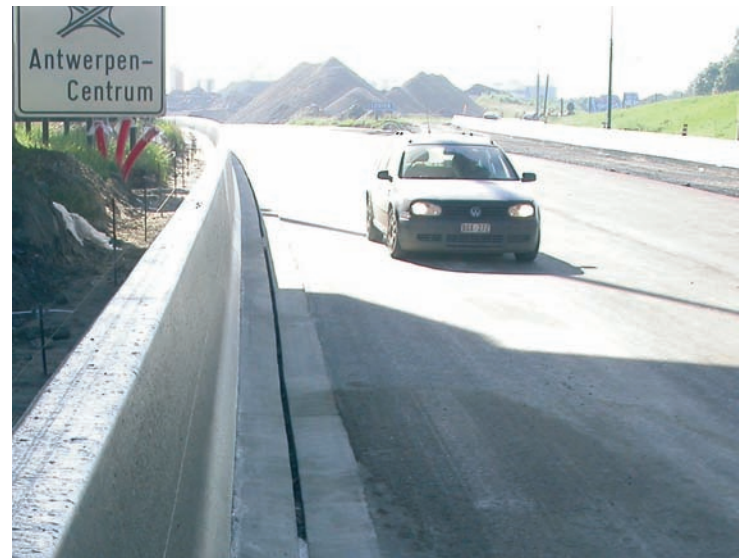
Zicht op de betonnen veiligheidsstootband en de verholen goot
