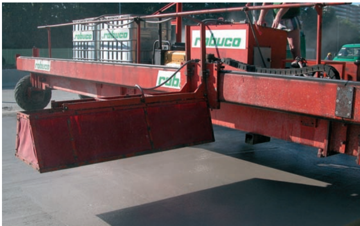
Verstuiven van de bindingsvertrager onmiddellijk na het betonneren
