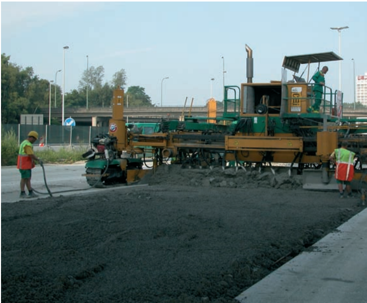
Zicht op de glijbekistingsmachine en de extra manuele verdichting van het beton langsheen de randen
