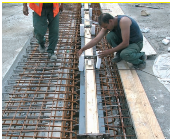
Zicht op het wapeningsstaal van de eindvoeg
