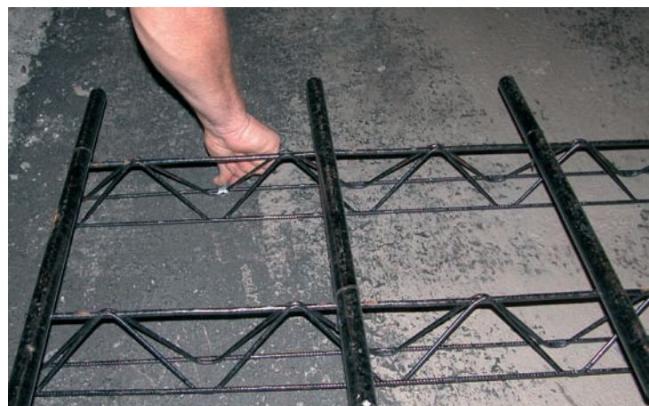
Plaatsen van de deuvels voor het platenbeton in de Kennedytunnel
