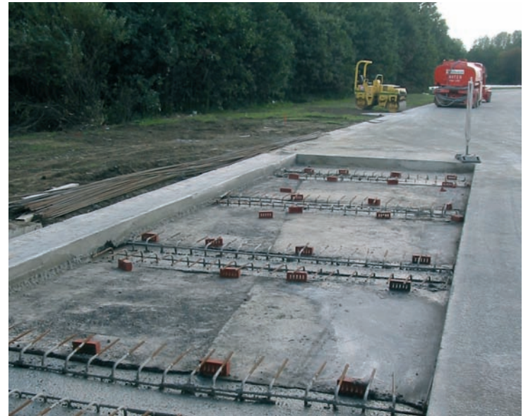
Zicht op het verankeringslandhoofd bestaande uit vier ribben
