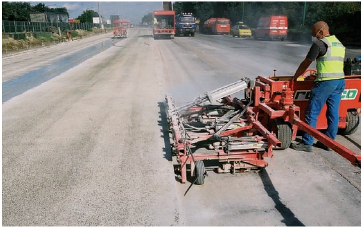
Boren van de gaten voor de ankerstaven
