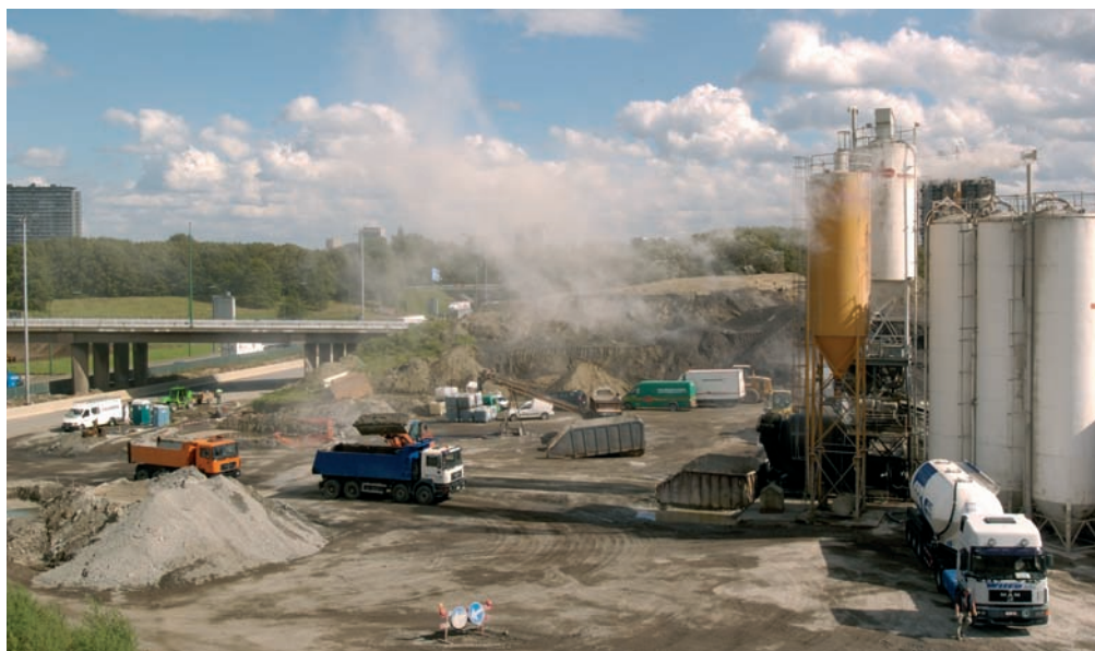
Zicht op de betoncentrale, opgesteld langs de werf
