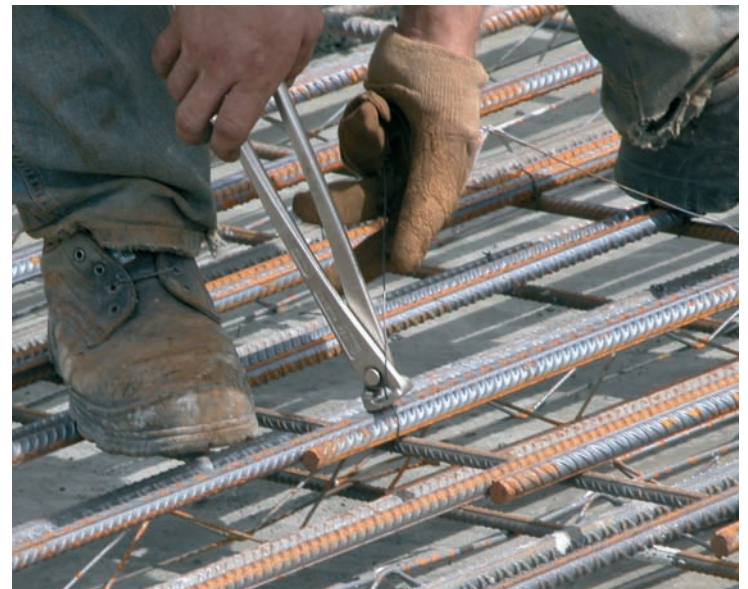
Plaatsen van wapening boven het verankeringslandhoofd
