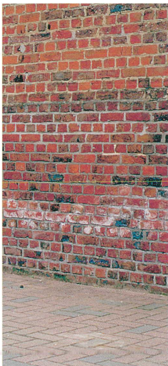
5 - Efflorescence due à des sels contenus dans le sol
