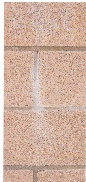
4 - Exsudation secondaire sous joint vertical mal fermé
