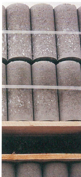
3 - Exsudation secondaire sur des éléments préfabriqués, stockés sans protection
