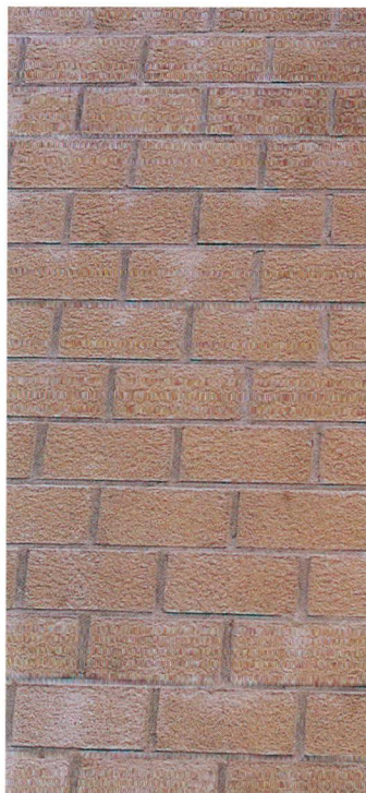
2 - Exsudation primaire (et/ou secondaire) sur maçonnerie
