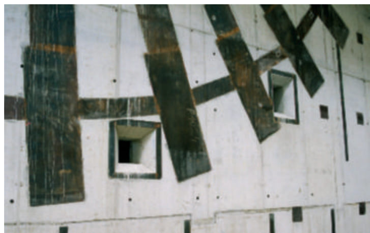
Bâtiment industriel complexe, réalisé en BAP coulé sur chantier
